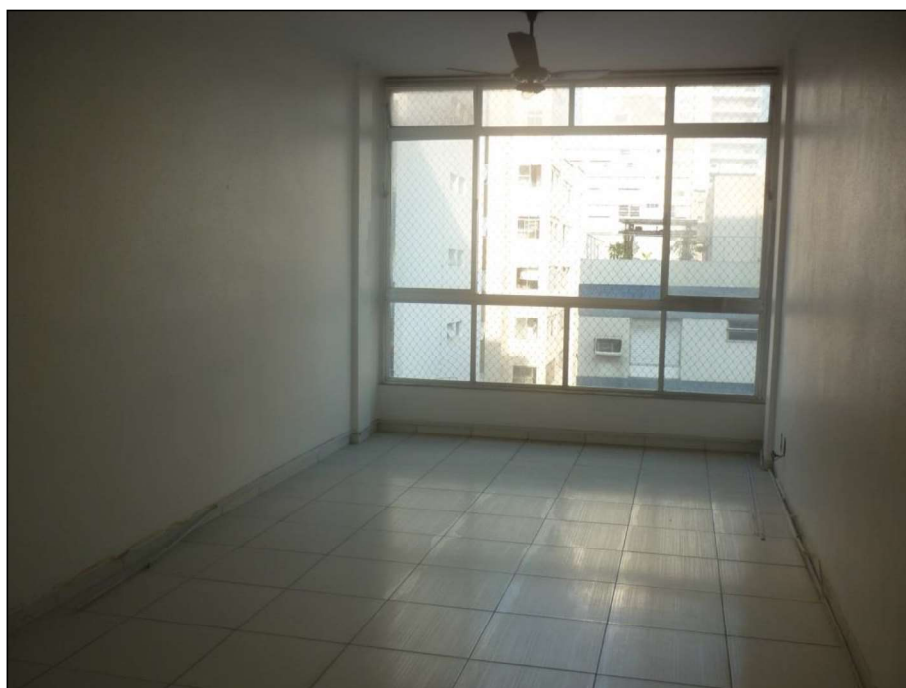
FOTO 03:- Vista da sala do imóvel.
