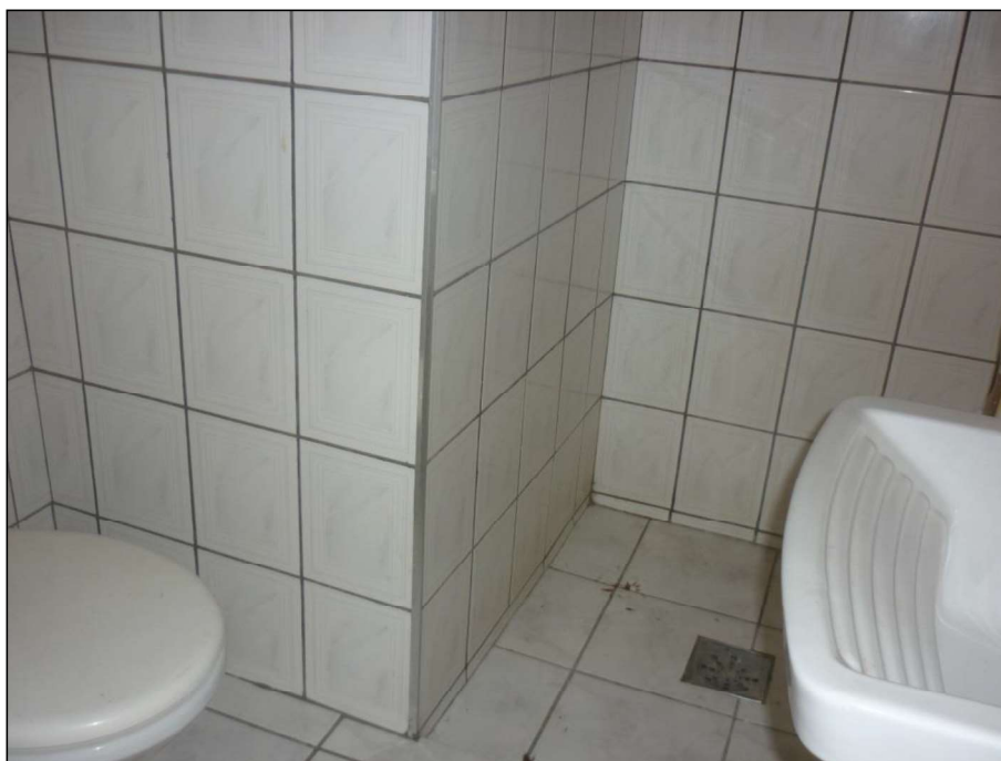
FOTO 04:- Vista do banheiro do imóvel.
