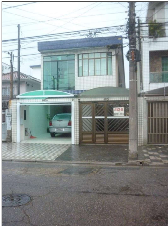
FOTO 07:- Vista do imóvel.
