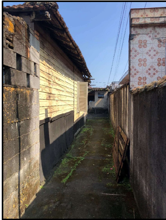
Foto 12: Acesso à edícula
