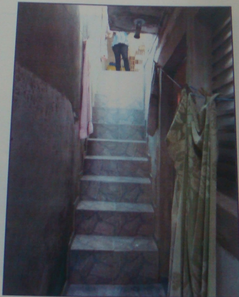
ESCADA DE ACESSO A CASA 3.
