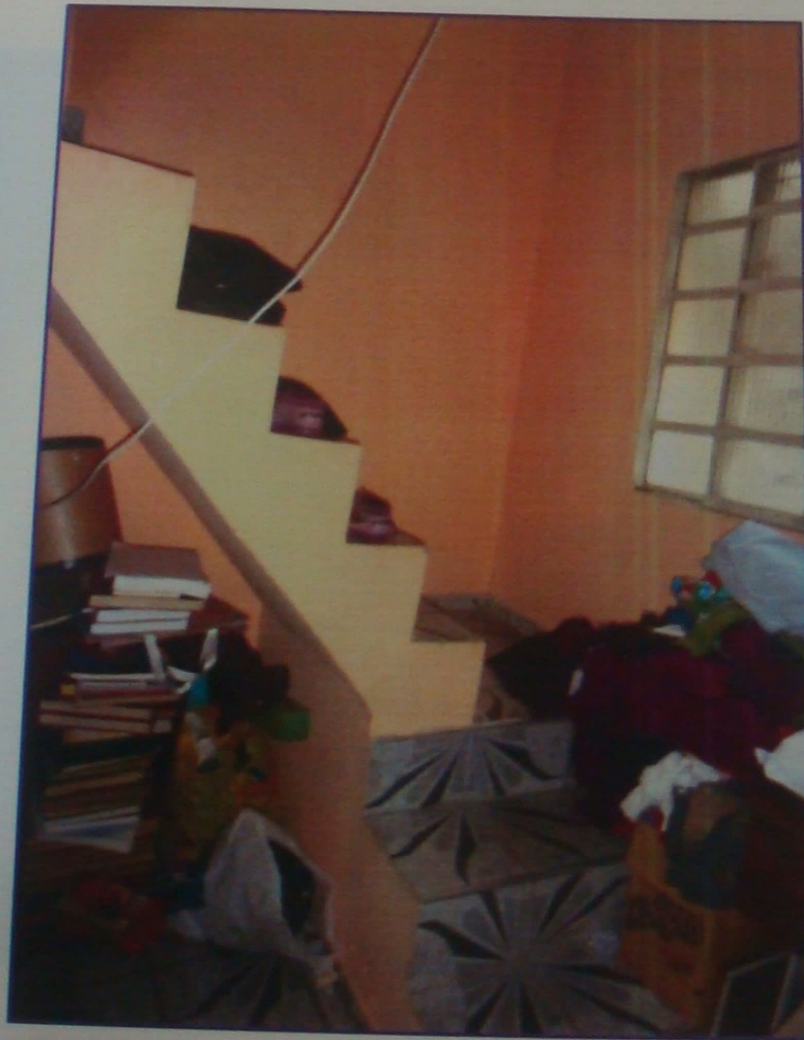
ESCADA DE ACESSO AO PAVIMENTO SUPERIOR.
