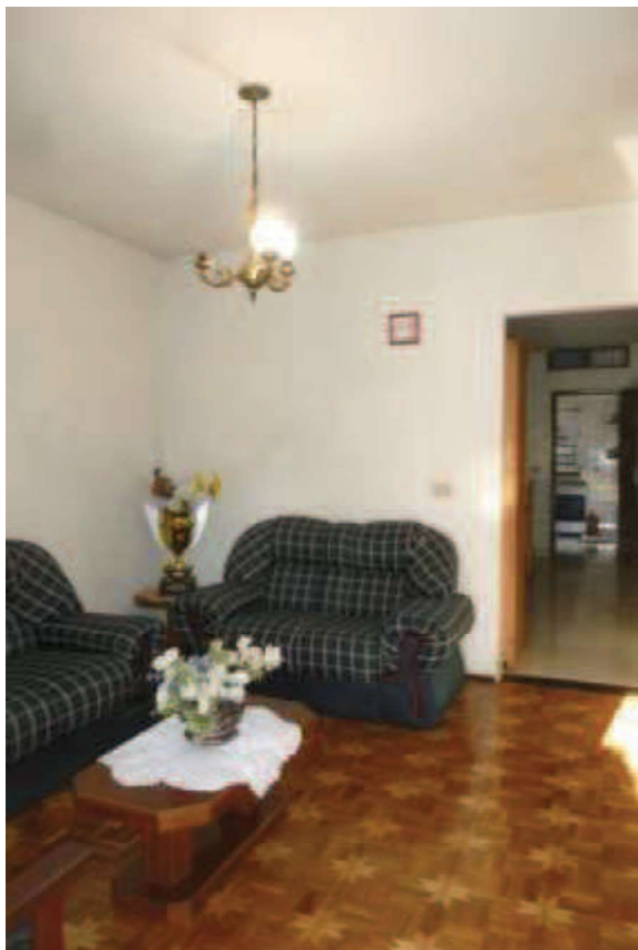
Foto 07 – Vista da Sala com laje de forro, piso em taco e pintura em bom estado.
