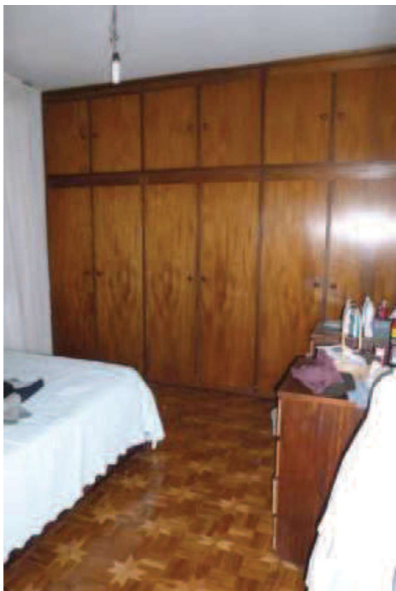
Foto 09 – Vista do quarto com laje de forro, piso em taco em bom estado de conservação.
