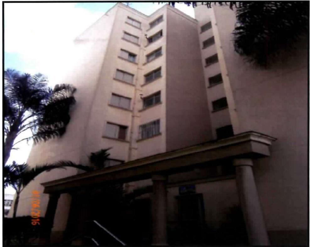
FOTO Nr.05: Vista da fachada lateral do Bloco B ou Edifício San Francisco.
