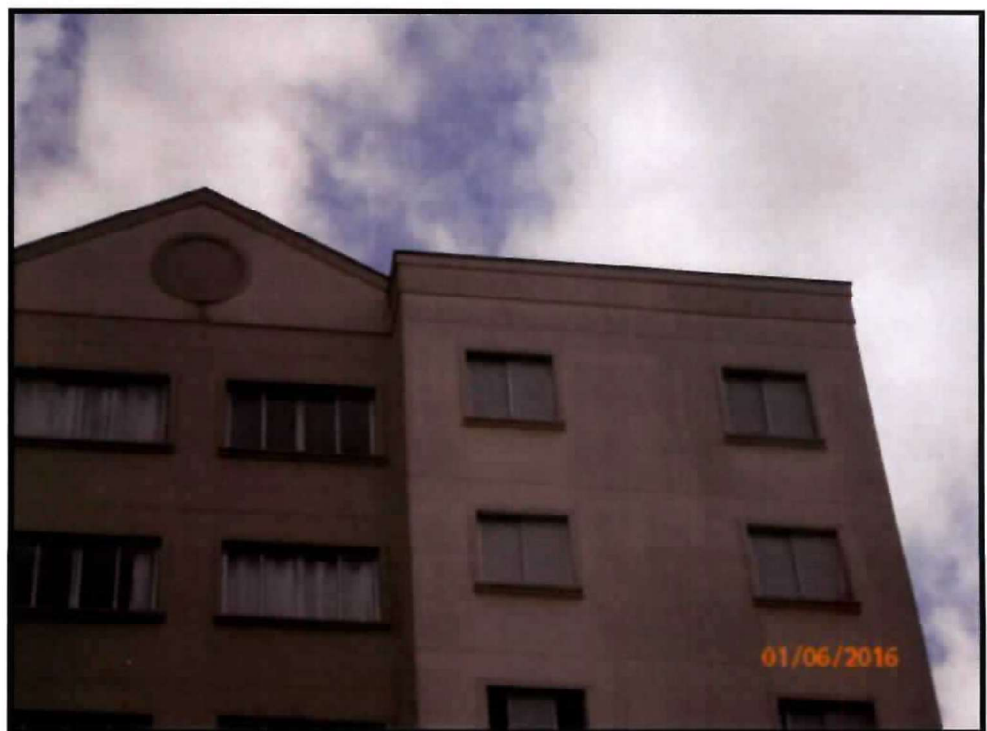
FOTO Nr.06: Vista do pavimento onde se encontra o apto 73 avaliando.
