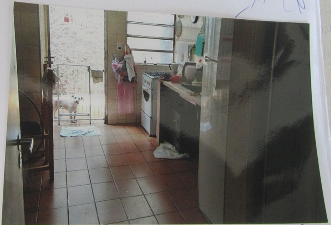
Foto nº 6 – cozinha com piso cerâmico e paredes revestidas de azulejos, pia com cuba inox e tampo de mármore.
