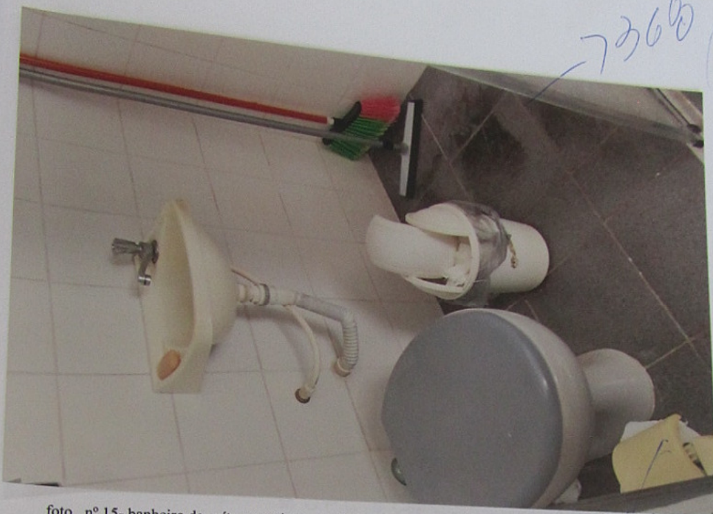
foto nº 15- banheiro da suíte com piso cerâmico, paredes de azulejos.
