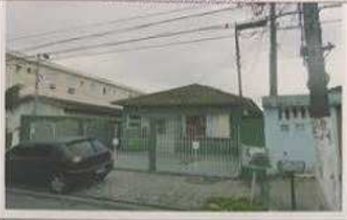
FOTO 03 - VISTA FRONTAL DA EDIFICAÇÃO QUE CONTÉM QUATRO CASAS RESIDENCIAIS
