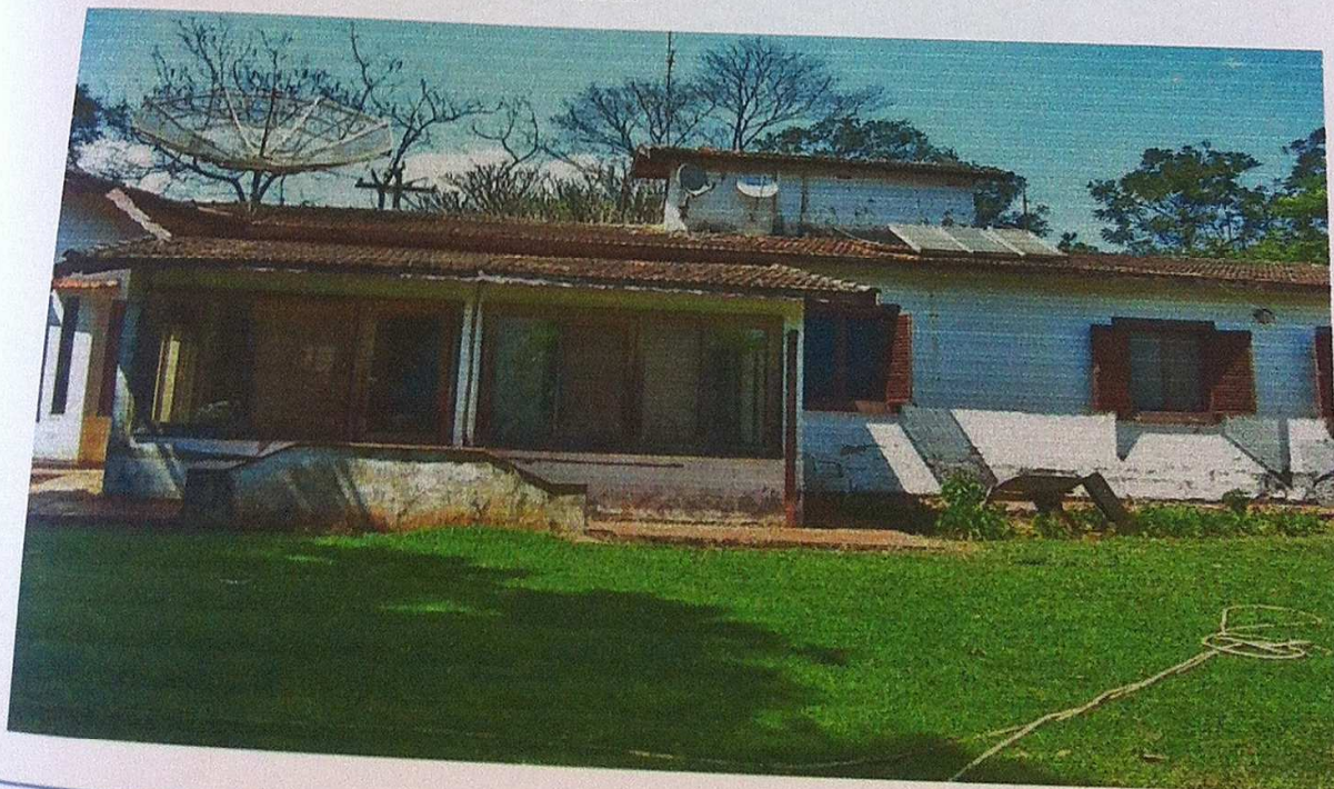
Paredes externas do imóvel com acabamento de reboco, massa fina, pintura em látex.
