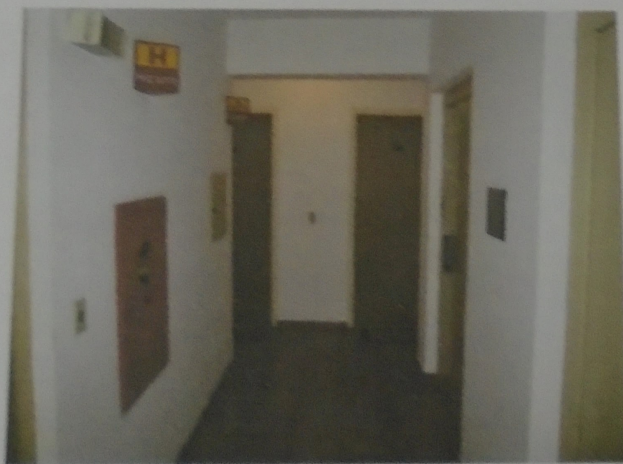
Foto nº 32 - Hall Social do 6º Pavimento
