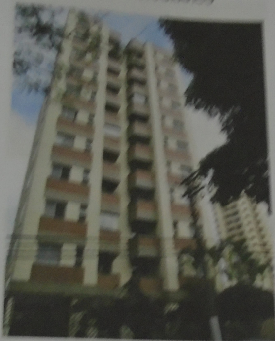
Foto nº 1 - Fachada do edifício
