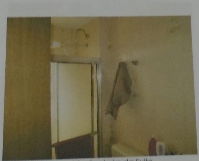
Foto nº 8 – Banheiro da Suite
