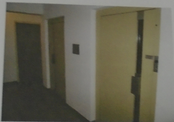
Foto nº 31 - Hall Social do 6º Pavimento
