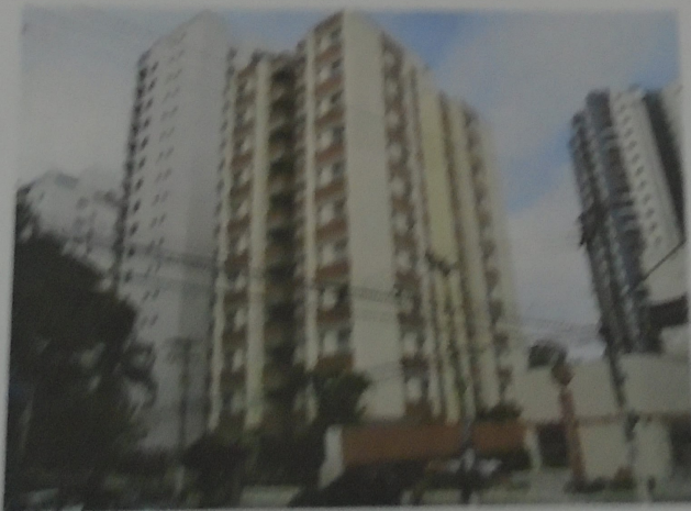
Foto nº 2 - Fachada do edifício, visto da Avenida Nova Cantareira
