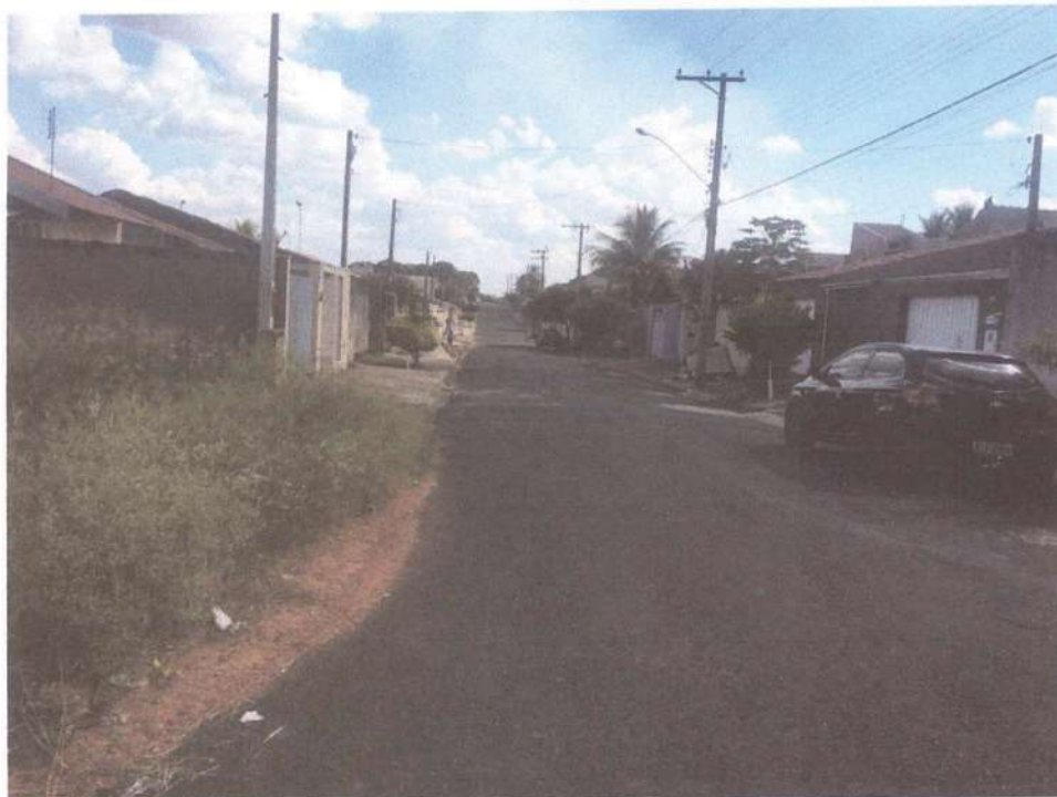
Foto 3 - Vista Rua Lado Esquerdo
