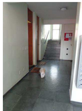
Foto 16 – Piso hall entrada bloco
