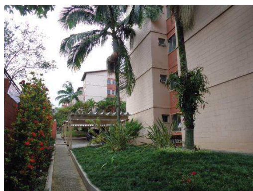
Foto 22 – Vista pátio interno
