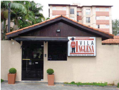
Foto 17 – Portaria Central Condomínio
