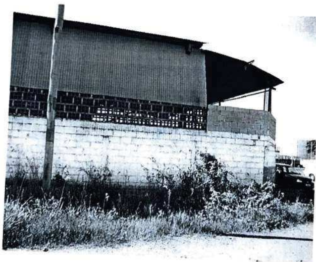
Foto 6 - Vista o imóvel avaliando pela Rua Barretos
