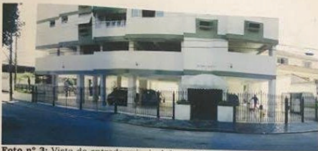
Foto nº 3: Vista da entrada principal do edifício com frente para a Rua Dr. Olavo de Paula Borges. Visualiza-se que o mesmo é composto de garagem no pavimento térreo e mezanino.
