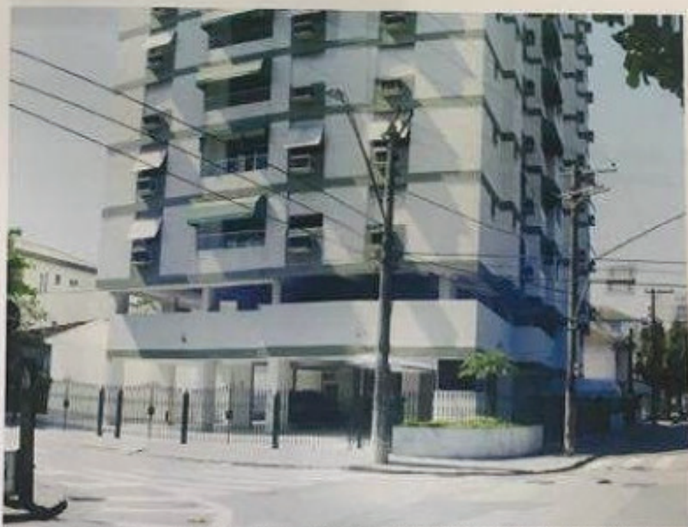
Foto nº 4: Vista da frente do Edifício para a Rua Cel. Pedro Arbues.
