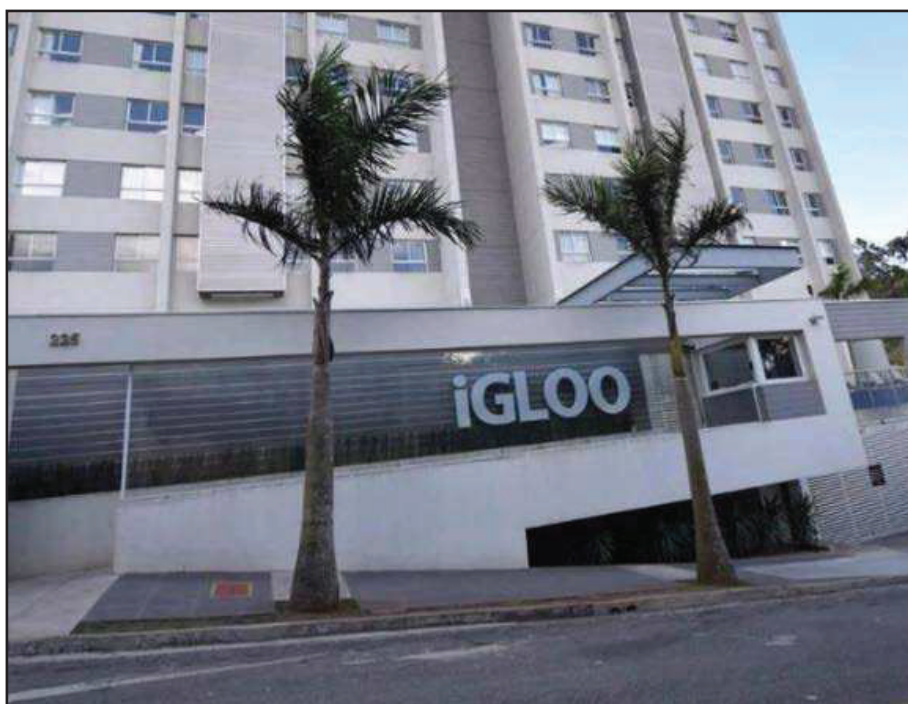
Foto 02: Vista das entradas do Condomínio.
