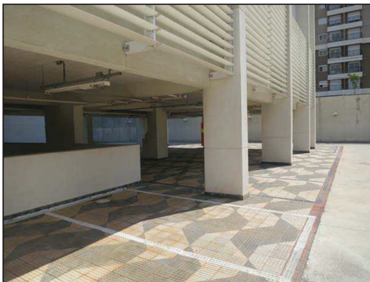
Fotos 14 e 15: Vistas da garagem do edifício.
