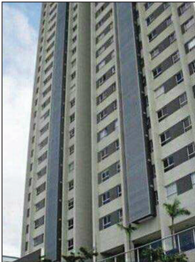
Foto 01: Vista da fachada principal do Edifício IGloo Alphaville.
