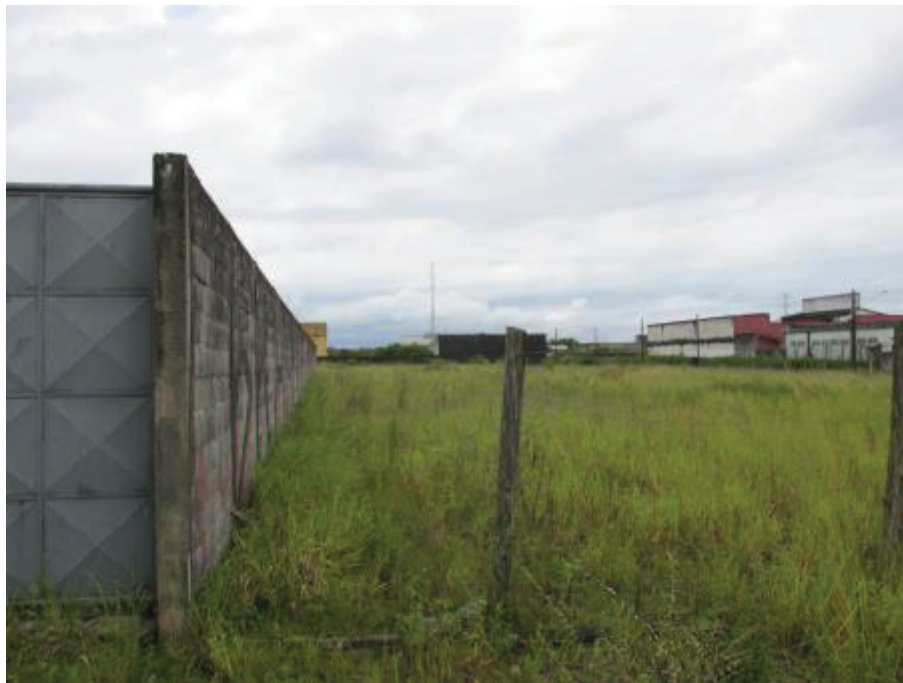
FOTO 10:- Vista dos fundos do lote 11 situado na esquina da Rua Valdomiro do Espírito Santo com a Rua Desembargador José Mauro Bourreat Ribeiro.
