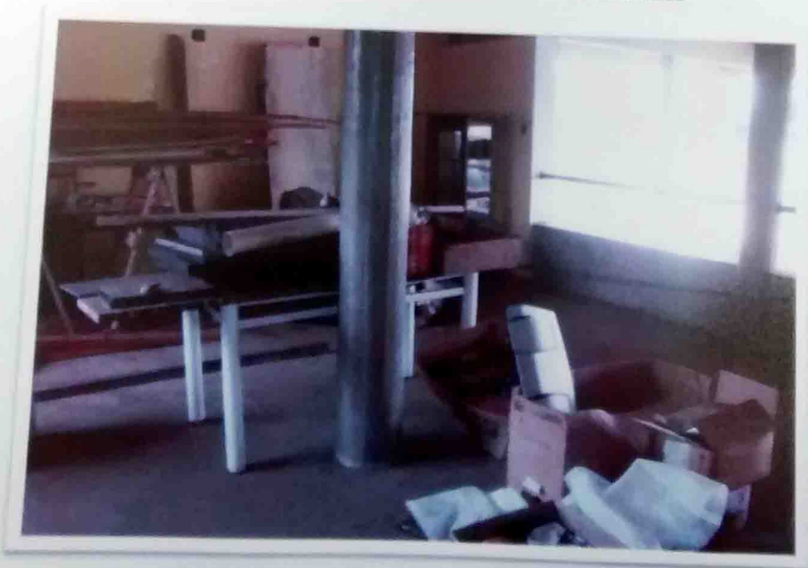
VISTAS PARCIAIS INTERNAS DO EDIFÍCIO COMERCIAL
