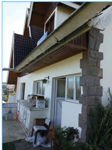
Figura 3– Vista do fundo do imóvel
