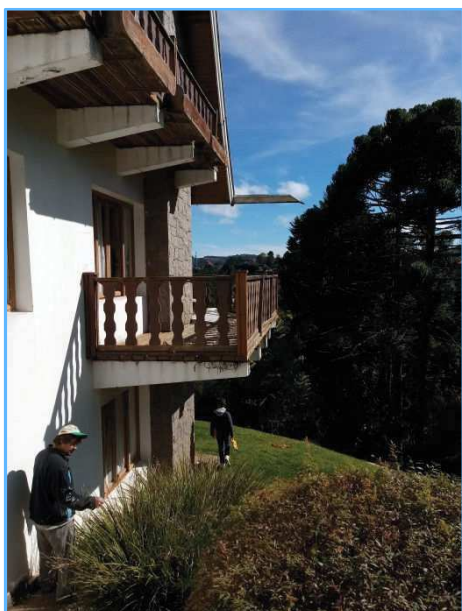
Figura 2– Vistada Lateral Direita do imóvel
