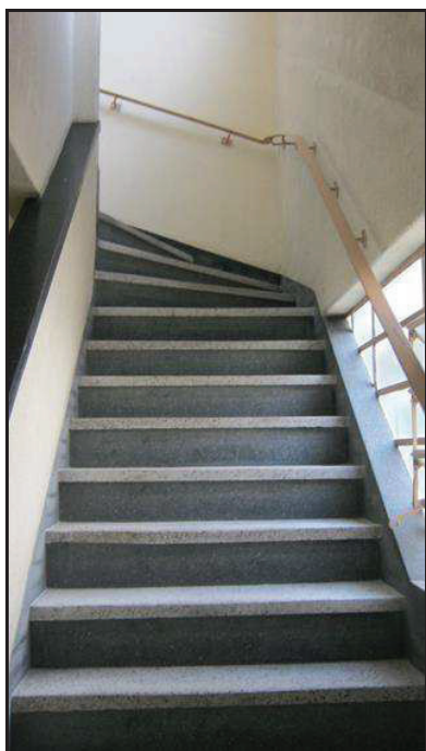
FOTO 10: Vista da escada de acesso do 6º andar para o 7º andar.
