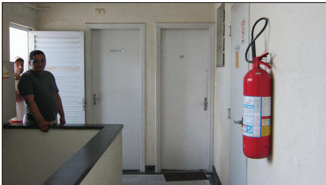
FOTO 03: Vista da porta de entrada do imóvel avaliando no hall do 7º andar, cujo acesso se dá por elevador até o 6º andar e, por escada até o entre o 6º e 7º andar.
