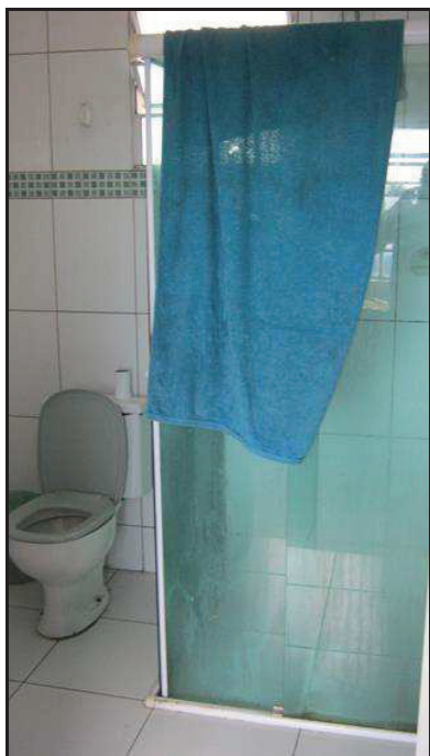
FOTO 09: Vista do banheiro do imóvel avaliando.
