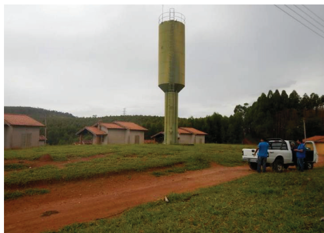
Foto 41: Vista da Caixa D'água elevada, que abastece os 45 Chalés.
