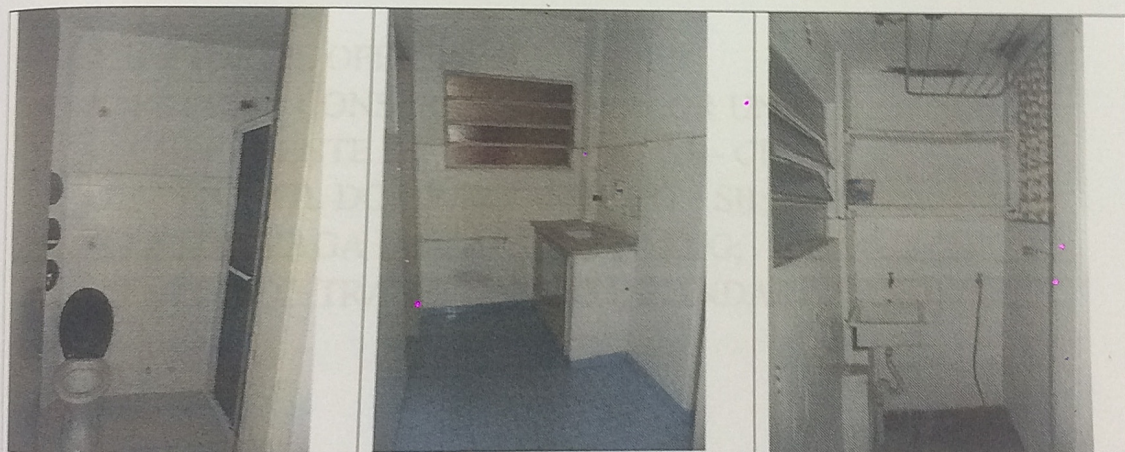
Características e estado de conservação dos cômodos da unidade 126.
