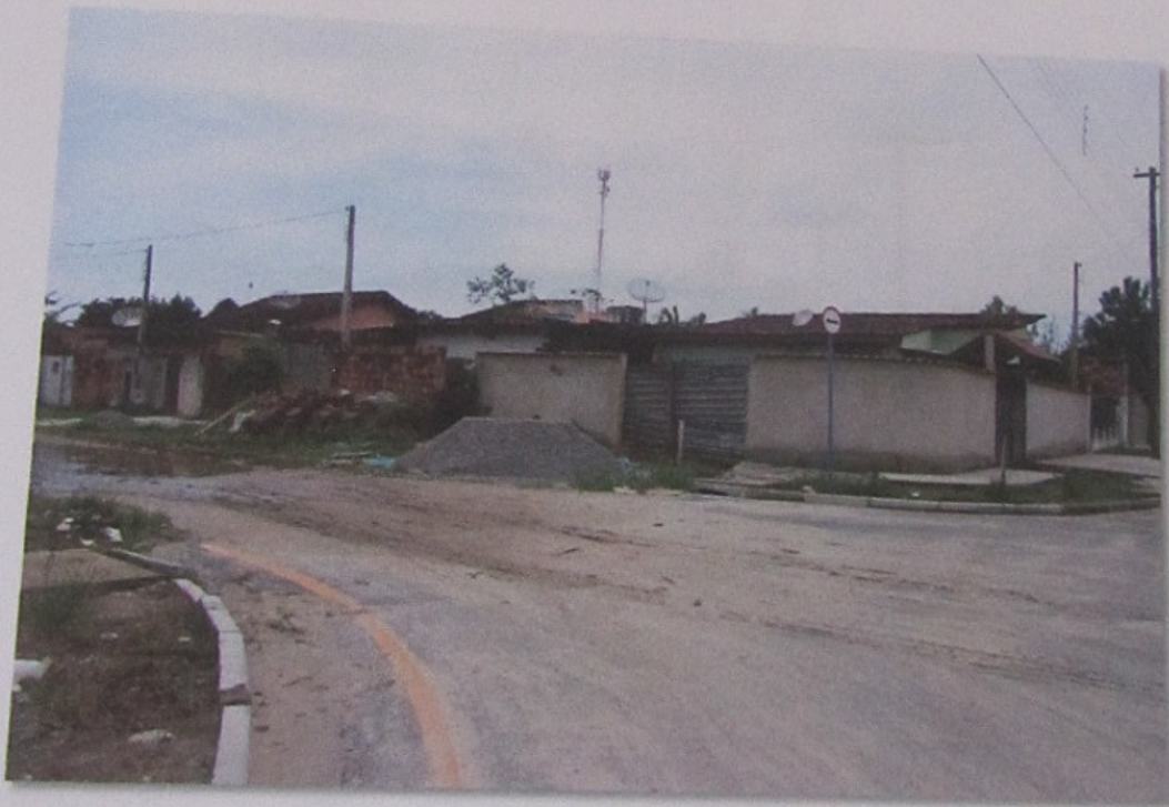
Foto 02 – Vista da frente secundária do Imóvel Avaliando.
