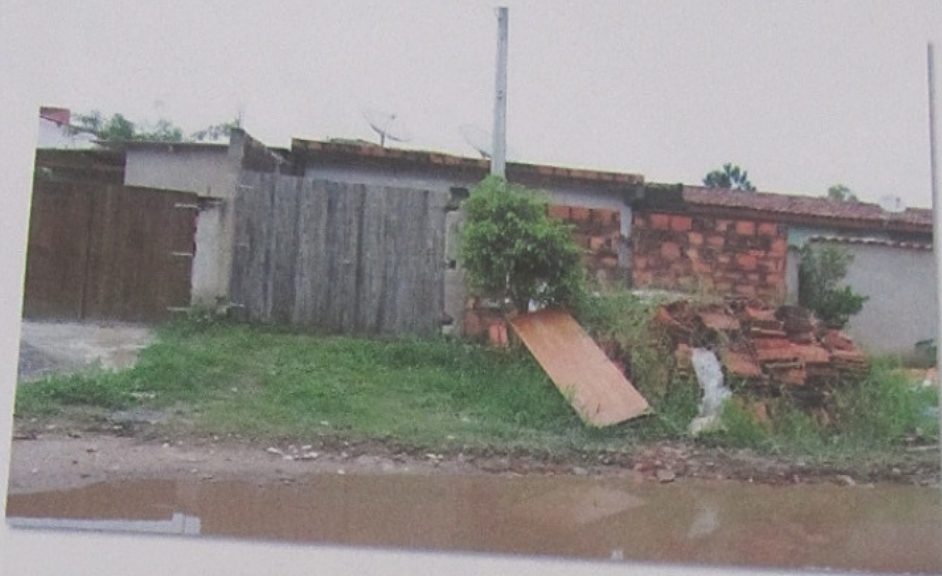
Foto 05 – Vista da frente secundária e quinhão correspondente à benfeitoria nº 02.
