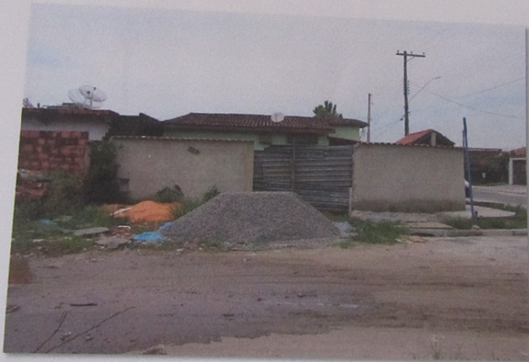
Foto 04 – Vista da frente secundária e quinhão correspondente à benfeitoria nº 01.
