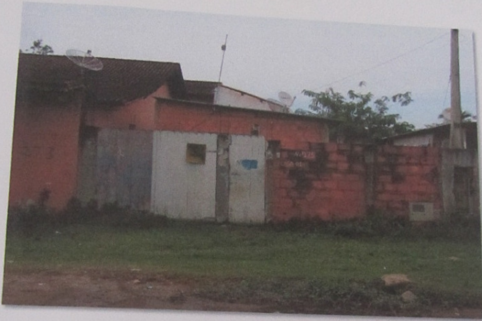
Foto 06 – Vista da frente secundária e quinhão correspondente à benfeitoria nº 04.
