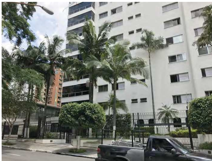
Foto 2- Outra vista da entrada do Edifício.
