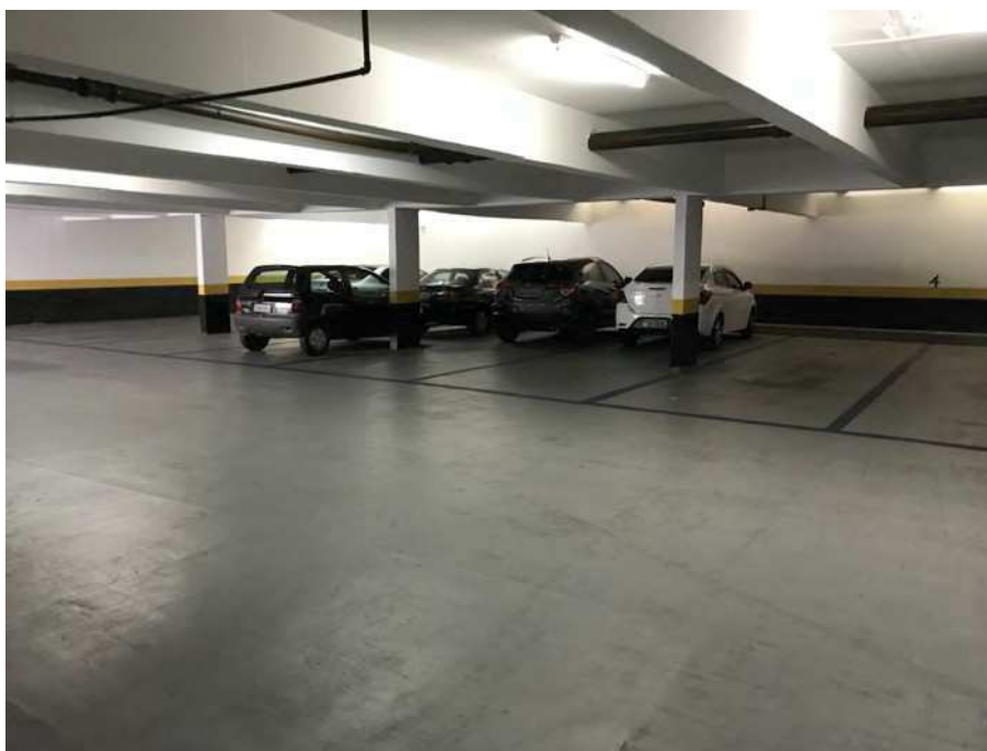
Foto 22- Vista da garagem do edifício.
