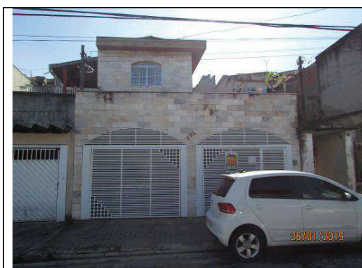
Foto n.º 8. Comparativo n.º 8, localizado na Rua Armando Rocha, n.º 594.
