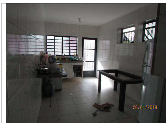
Foto n.º 10. Vista da copa/cozinha no 1.º pavimento do corpo principal.
