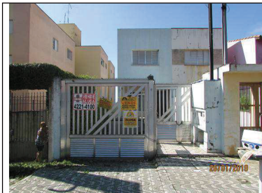
Foto n.º 5. Comparativo n.º 5, localizado na Rua Angelina, n.º 69.
