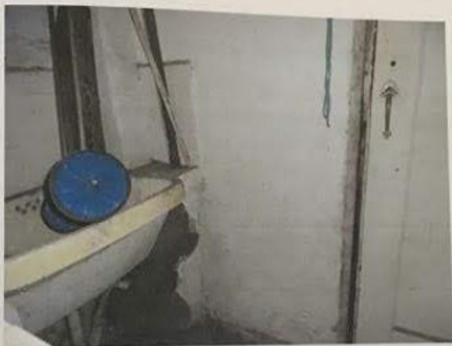
FOTO 09: - Vista da área de serviço do imóvel.
