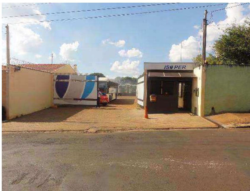
Vista do Imóvel Avaliando, localizado na Rua Amapá, nº 280, Centro, Cidade de São Joaquim da Barra, Estado de São Paulo, matriculado sob nº 4.545, no Primeiro CRI de São Joaquim da Barra.
