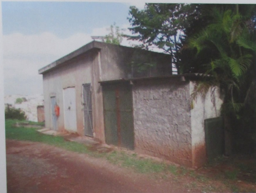
Foto 62: Vista interna do terreno e externa da edificação do imóvel avaliando.
