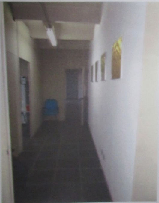
Foto 71: Vista do piso mezanino do galpão.
