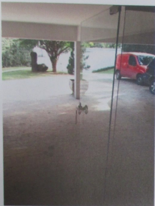
Foto 39: Vista do piso inferior do imóvel avaliando.
