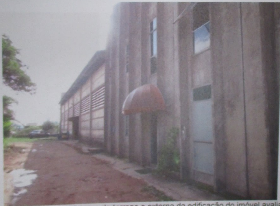
Foto 61: Vista interna do terreno e externa da edificação do imóvel avaliando.
