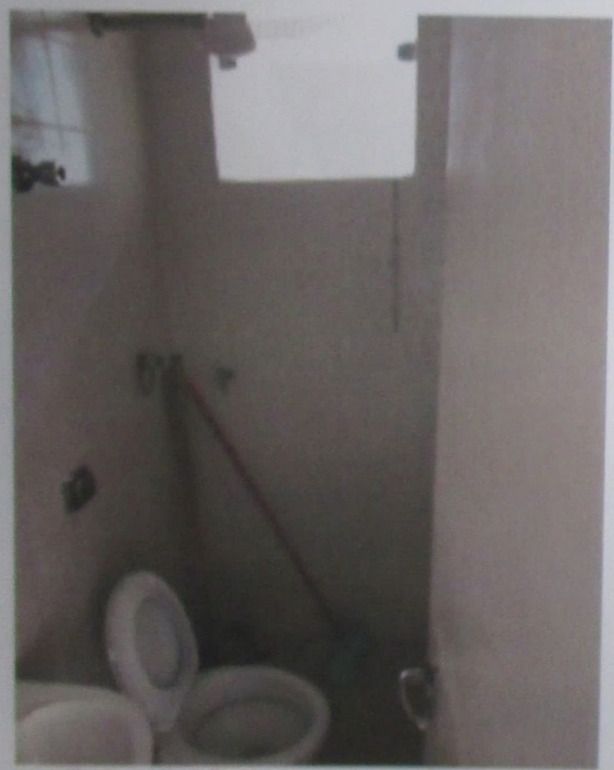
Foto 16: Vista do WC de empregada do imóvel avaliando.
