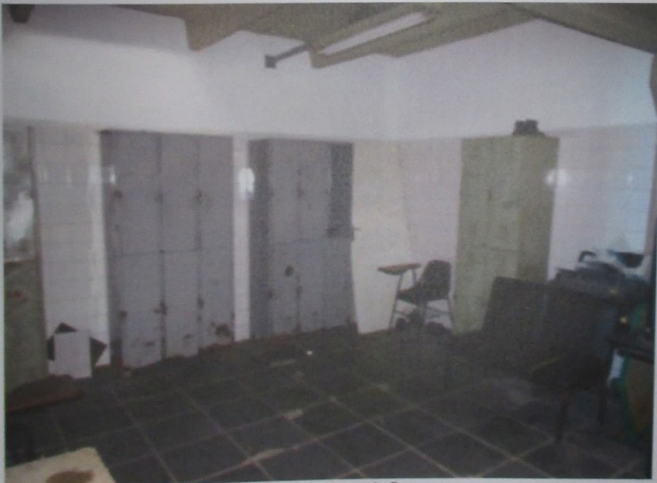
Foto 79: Vista do piso mezanino do galpão.
