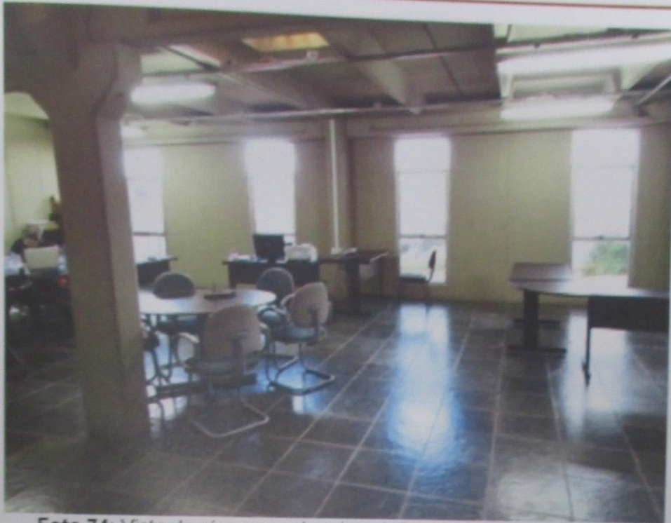
Foto 74: Vista do piso mezanino do galpão.
