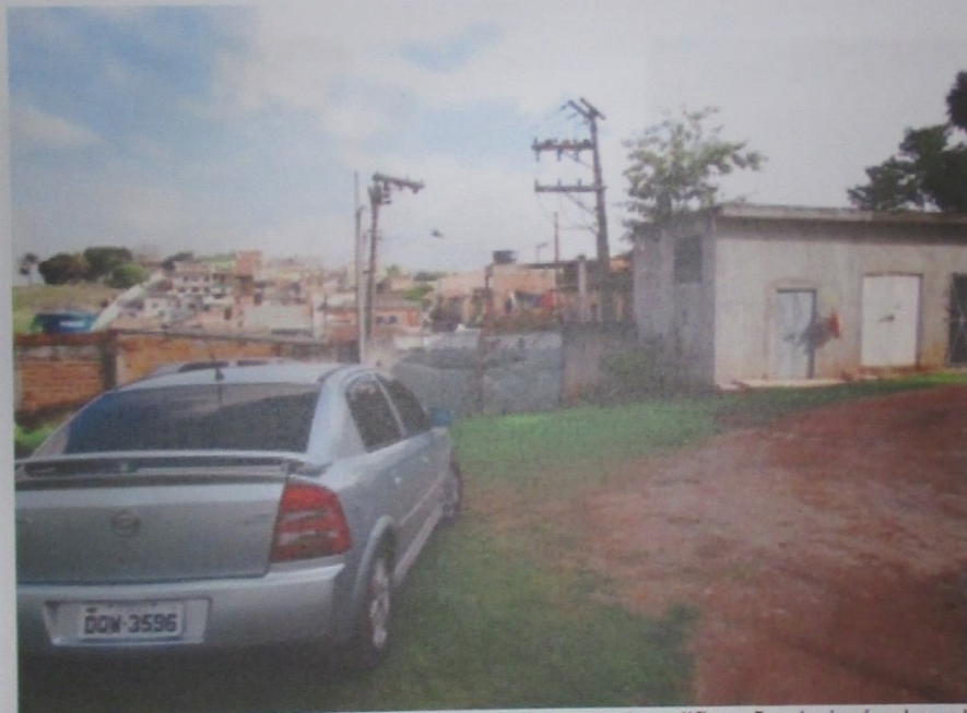
Foto 57: Vista interna do terreno e externa da edificação do imóvel avaliando.
