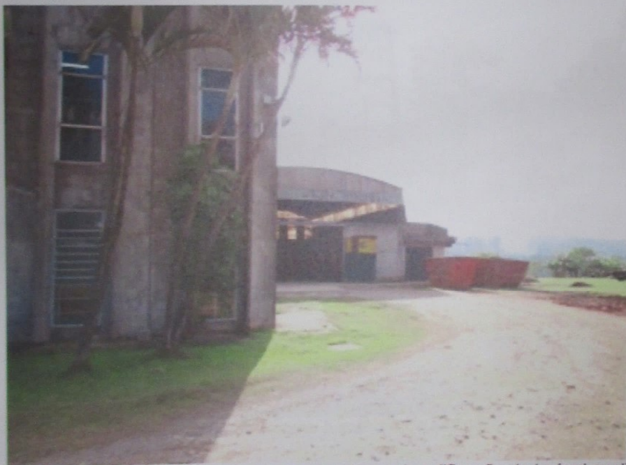
Foto 55: Vista interna do terreno e externa da edificação do imóvel avaliando.
