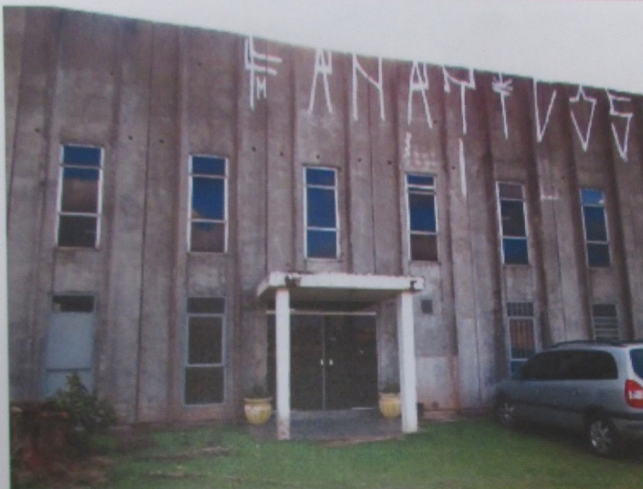
Foto 58: Vista interna do terreno e externa da edificação do imóvel avaliando.
