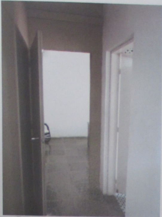
Foto 68: Vista do piso mezanino do galpão.
