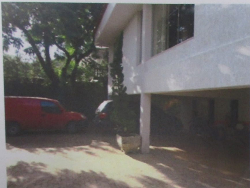
Foto 43: Vista externa da casa edificada do imóvel avaliando.
