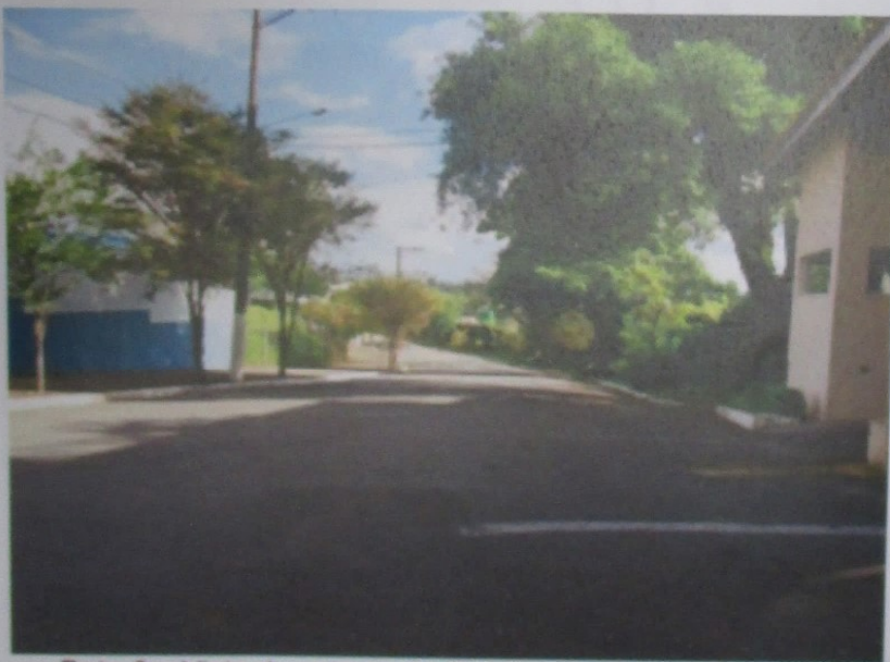
Foto 2: Vista da entrada do Condomínio Jardim Pasárgada I.
