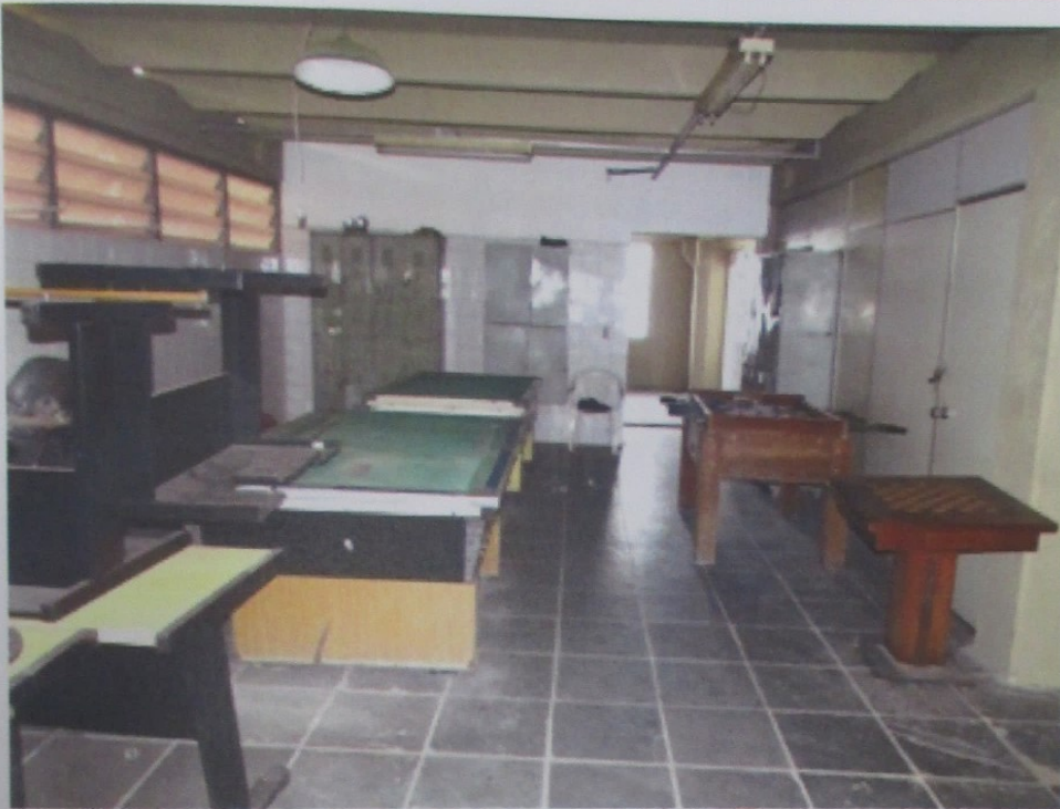
Foto 78: Vista do piso mezanino do galpão.
