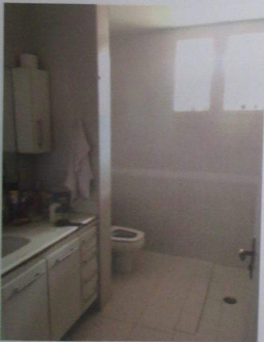
Foto 34: Vista do WC social do imóvel avaliando.
