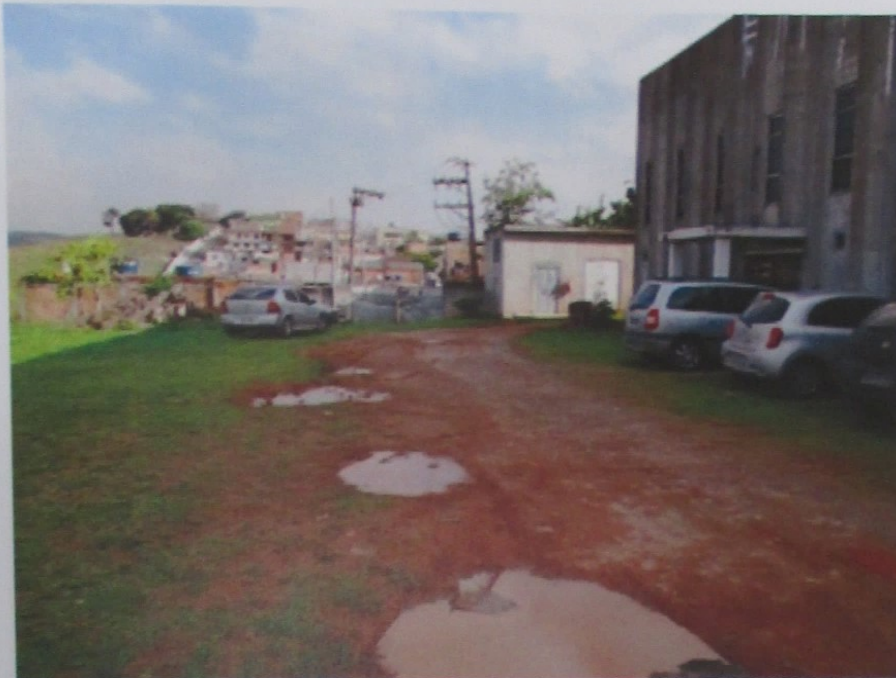
Foto 56: Vista interna do terreno e externa da edificação do imóvel avaliando.
