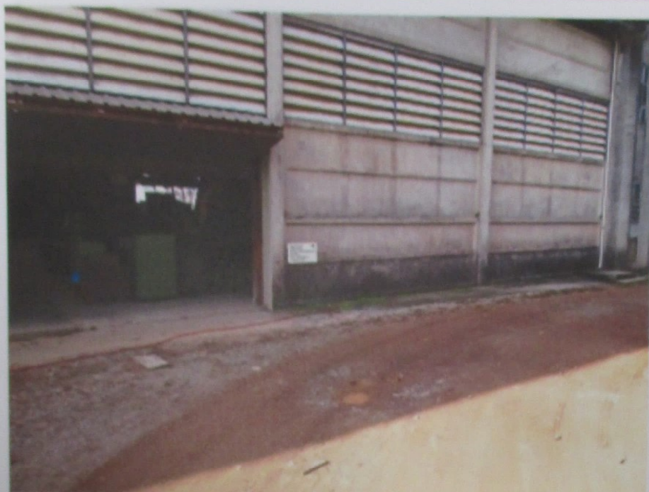
Foto 66: Vista interna do terreno e externa da edificação do imóvel avaliando.
