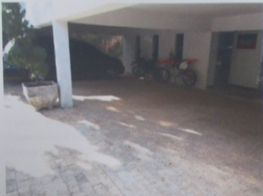
Foto 45: Vista externa da casa edificada do imóvel avaliando.
