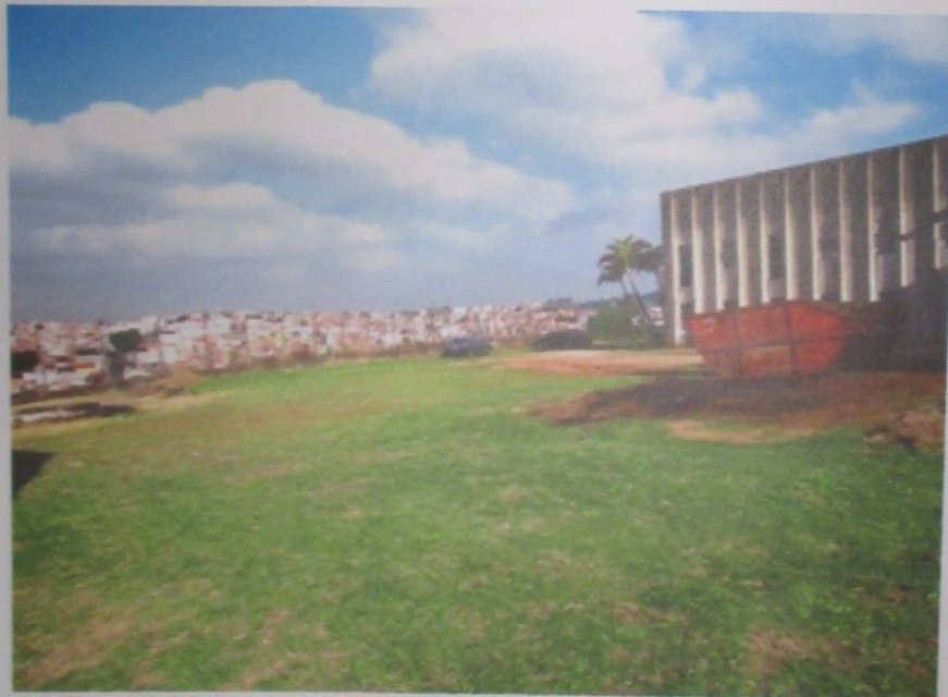
Foto 53: Vista interna do terreno e externa da edificação do imóvel avaliando.
