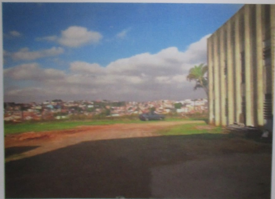
Foto 49: Vista interna do terreno e externa da edificação do imóvel avaliando.
