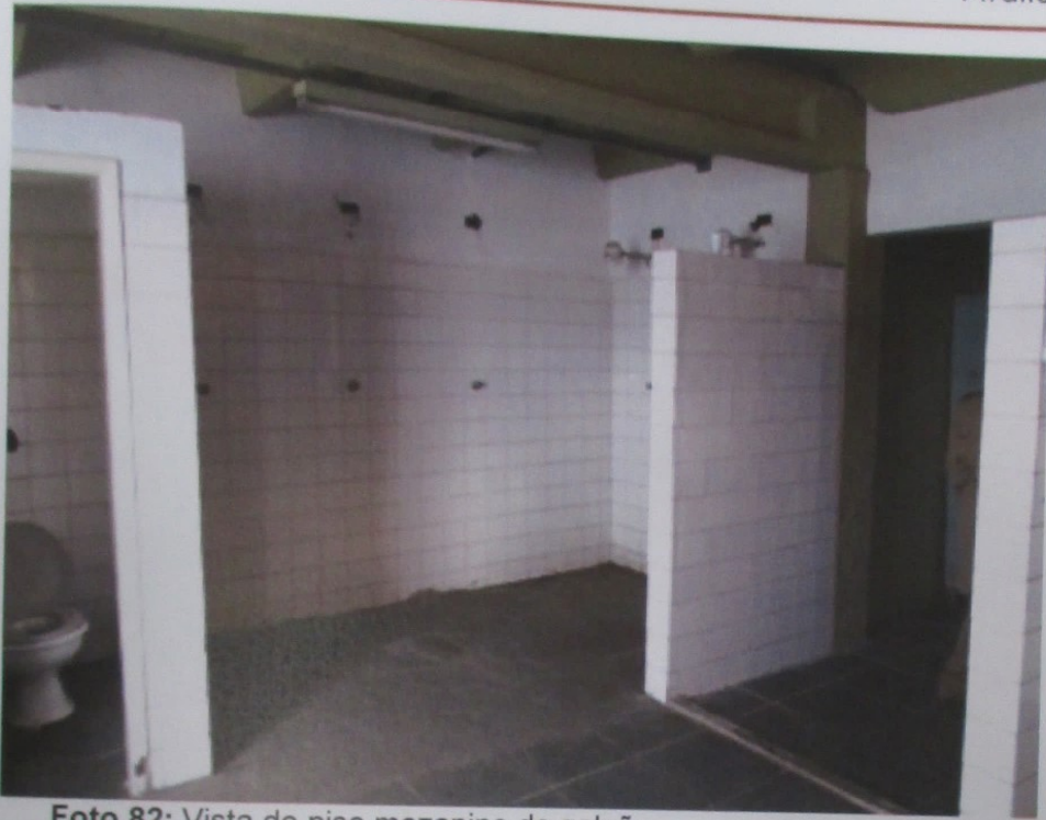
Foto 82: Vista do piso mezanino do galpão.
