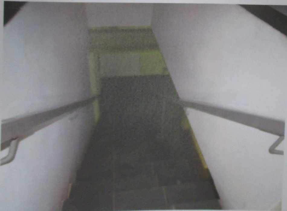
Foto 83: Vista da escada de acesso entre pisos do galpão.
