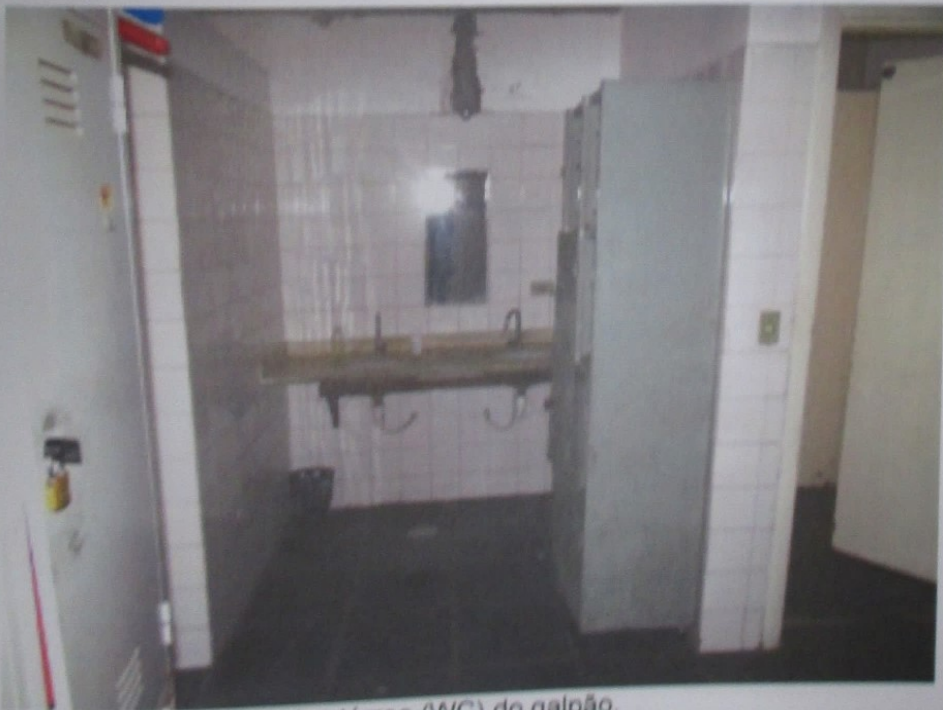
Foto 85: Vista do piso térreo (WC) do galpão.
