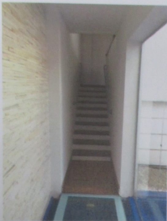
Foto 27: Vista da passagem para área dos dormitórios do imóvel avaliando.
