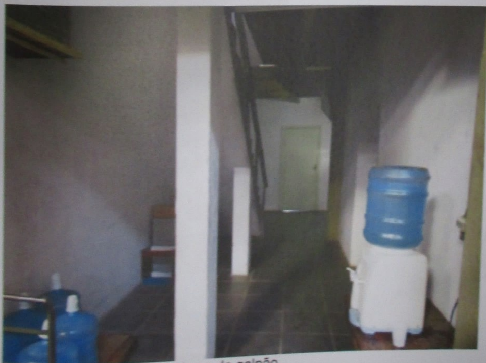
Foto 91: Vista do piso térreo do galpão.
