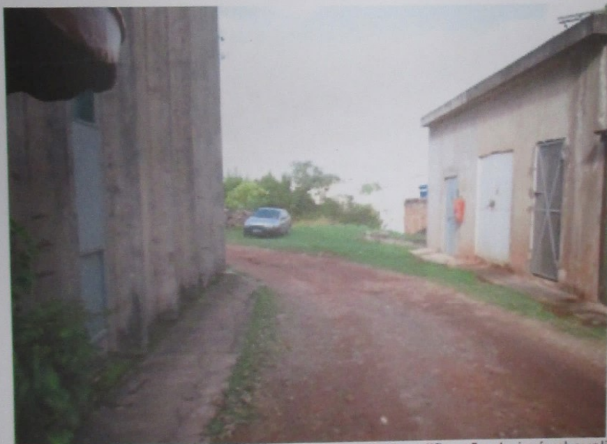
Foto 63: Vista interna do terreno e externa da edificação do imóvel avaliando.
