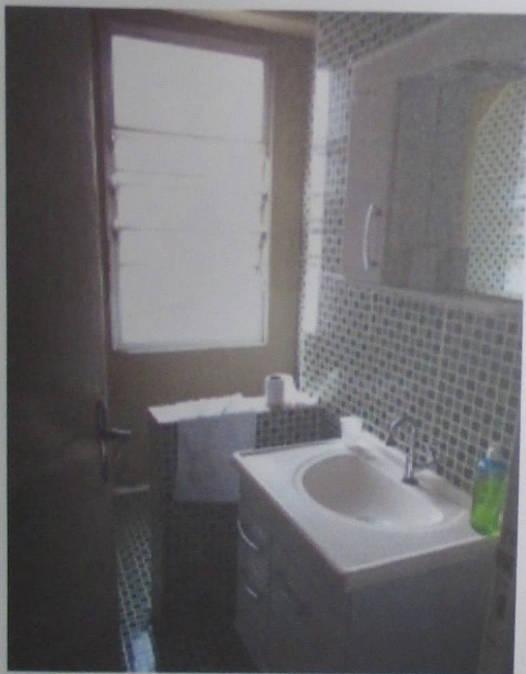
Foto 69: Vista do WC (escritório) do piso mezanino do galpão.
