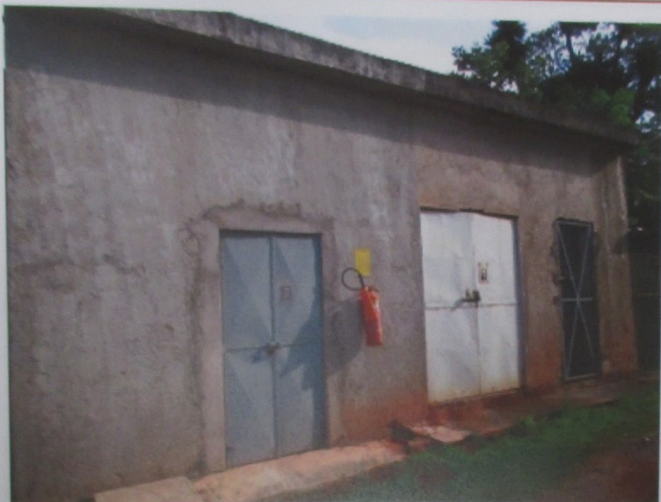
Foto 60: Vista interna do terreno e externa da edificação do imóvel avaliando.
