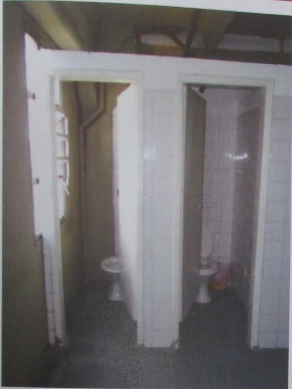
Foto 86: Vista do piso térreo (WC) do galpão.
