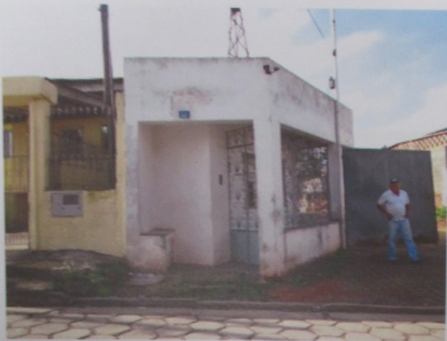
Foto 48: Vista da entrada do imóvel avaliando.
