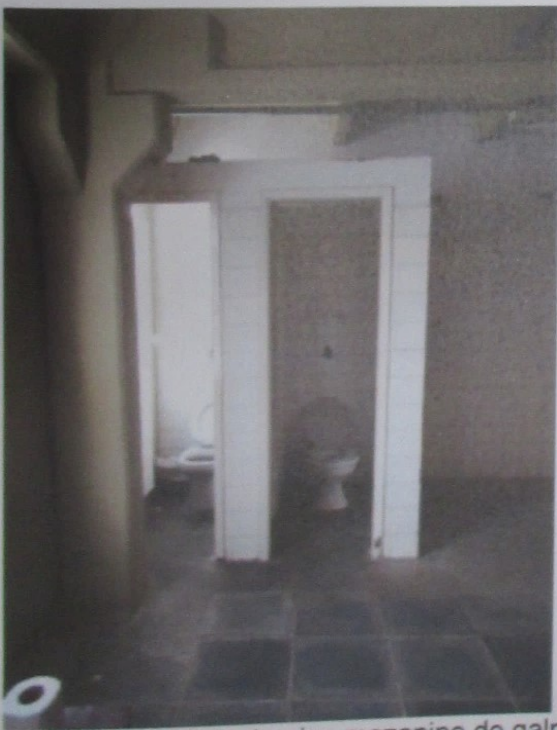
Foto 81: Vista do piso mezanino do galpão.
