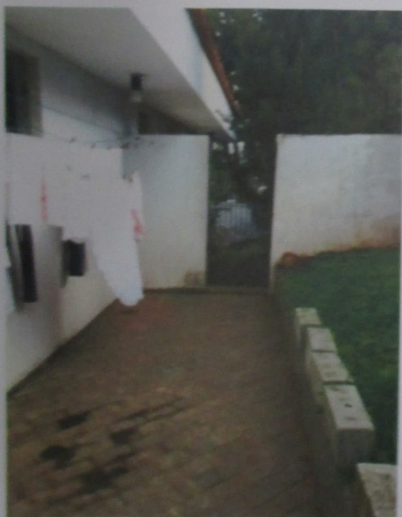
Foto 18: Vista externa da casa edificada do imóvel avaliando.
