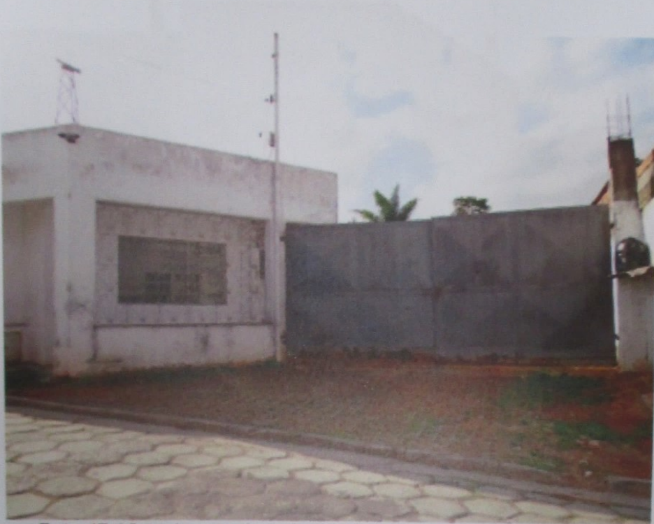
Foto 47: Vista da entrada do imóvel avaliando.
