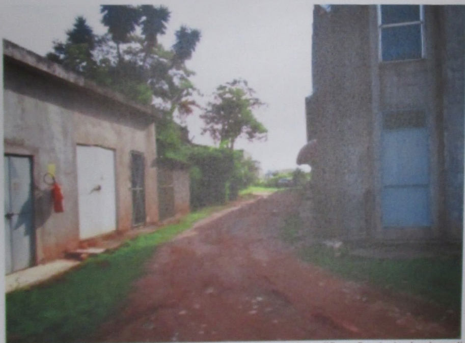
Foto 59: Vista interna do terreno e externa da edificação do imóvel avaliando.
