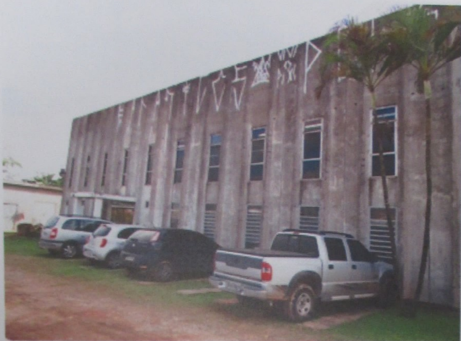
Foto 54: Vista interna do terreno e externa da edificação do imóvel avaliando.
