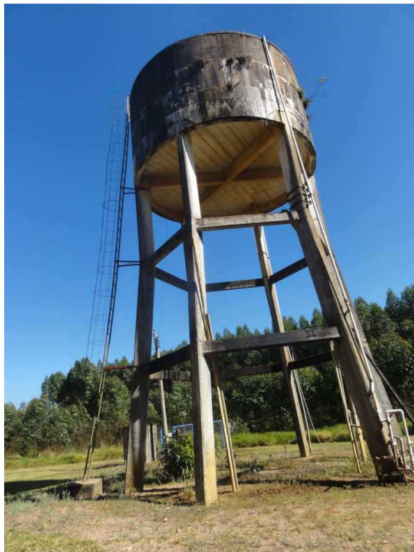
VISTA DA TORRE DA CAIXA D'ÁGUA.
