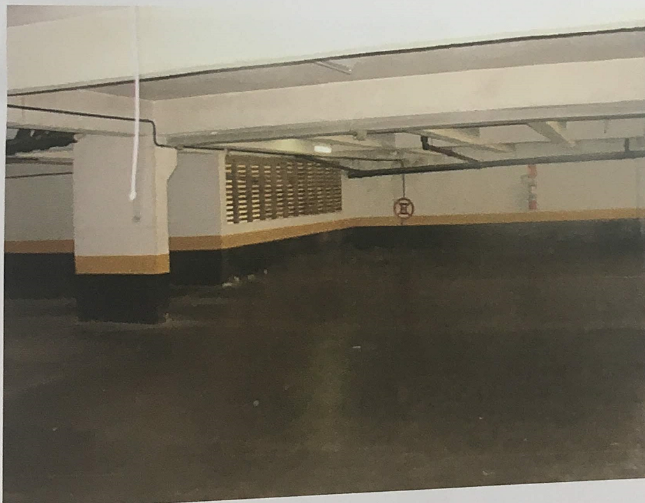
Foto 13. Vista do subsolo.
