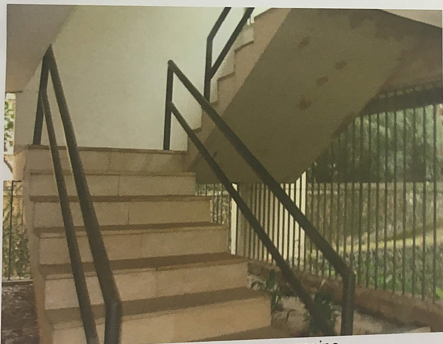
Foto 9. Vista da escada de acesso ao mezanino.
