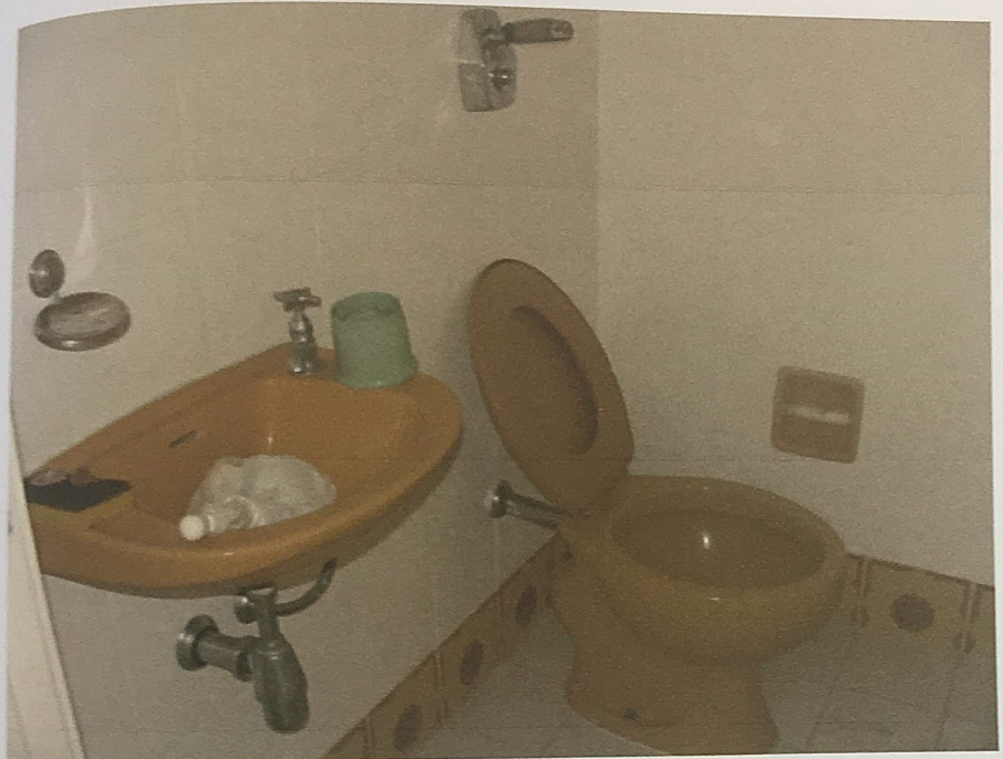
Foto 28. Vista parcial do banheiro de empregada.
