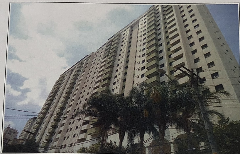
Vista parcial da fachada do edifício
