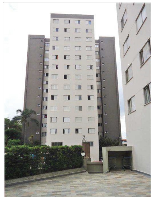
Bloco B – Edifício Elis
