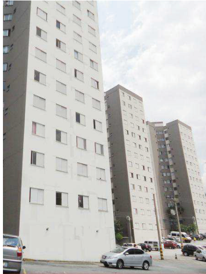
A. ESTR. DO SABÃO, 1403 CONJ. RESID.ALAMEDA DOS MÚSICOS
