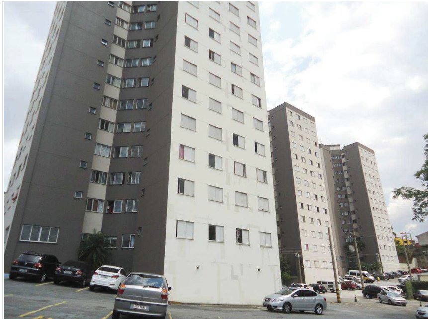
Vista do Fundo do Terreno – Blocos 1,2 e 3
