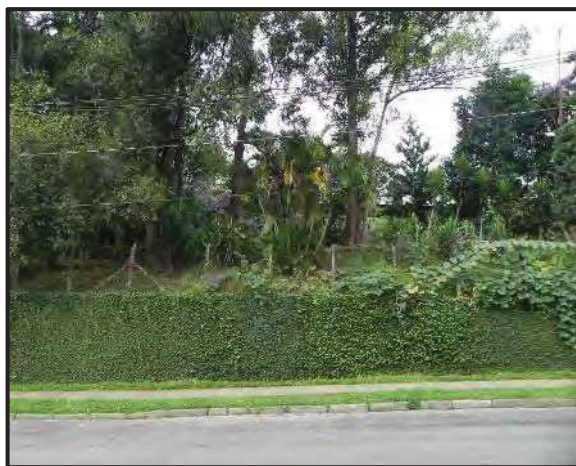
VISTA PARCIAL DO MURO FRONTAL DO IMÓVEL
