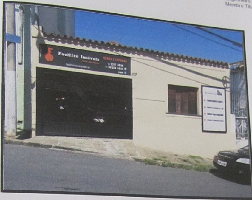
Vista da frente do imóvel avaliando para a Rua Albino Dantas.
