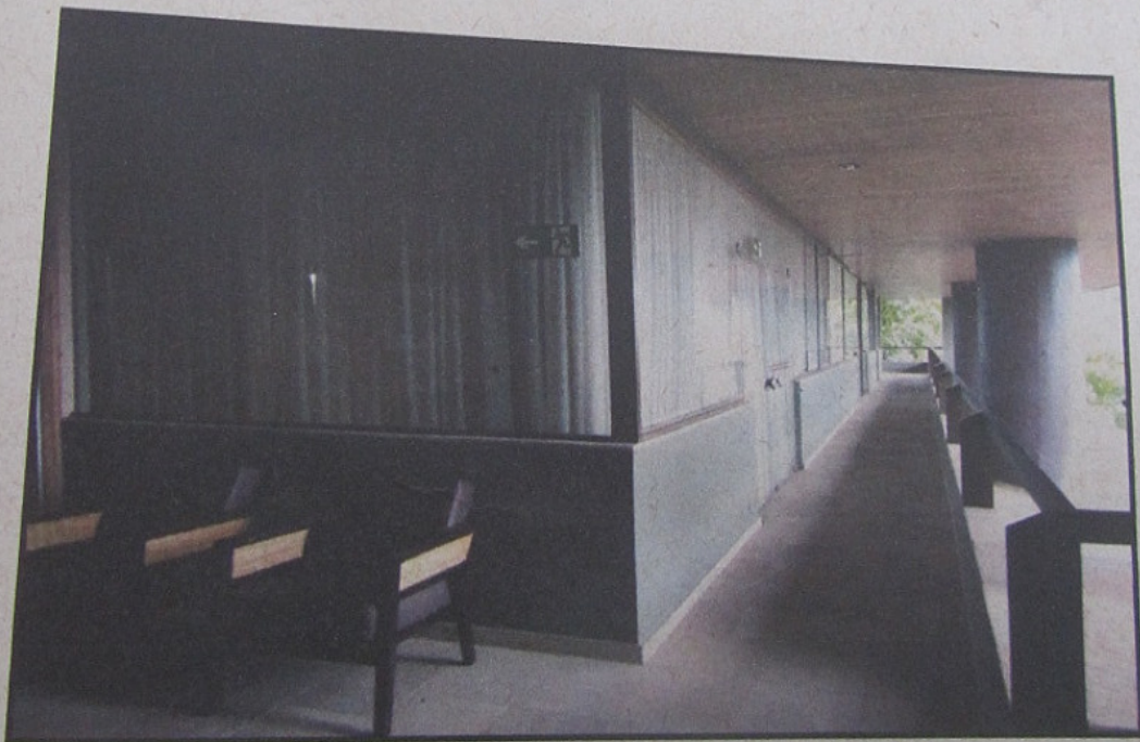
Vista área comum - Auditório, sala de reunião (desativados)
