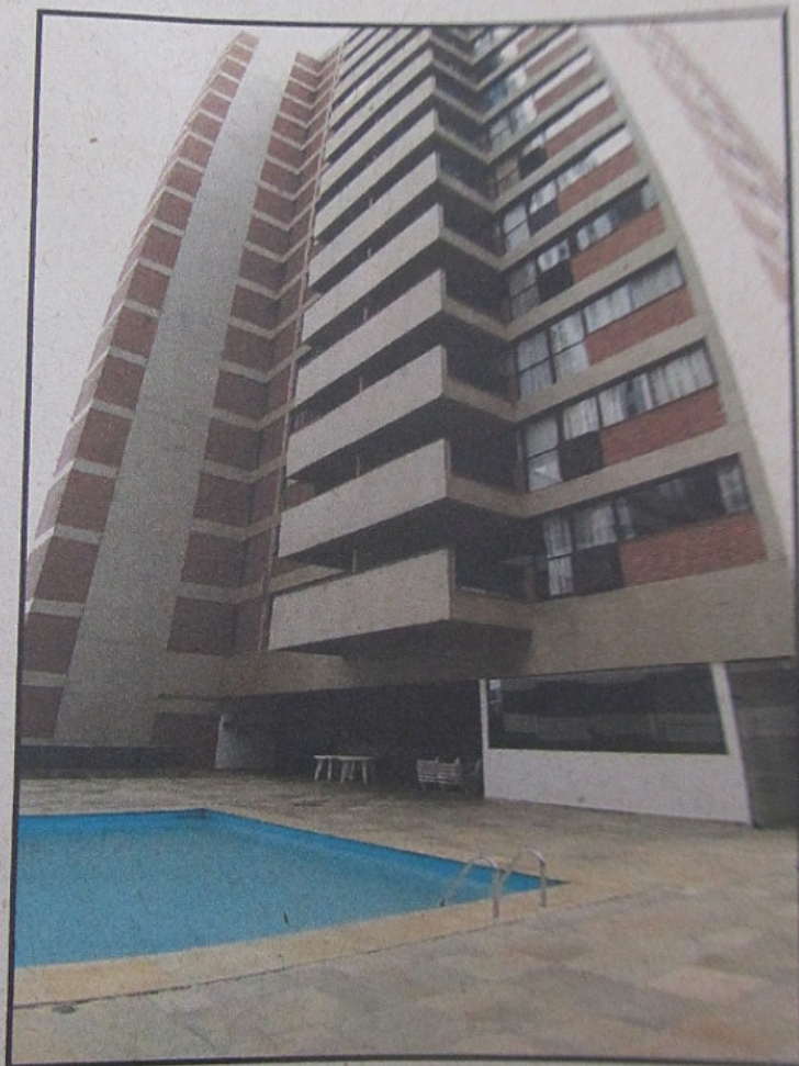
Vista 2 da área comum - Piscina
