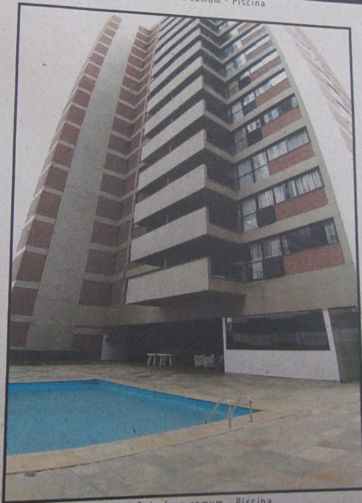
Vista 2 da área comum - Piscina
