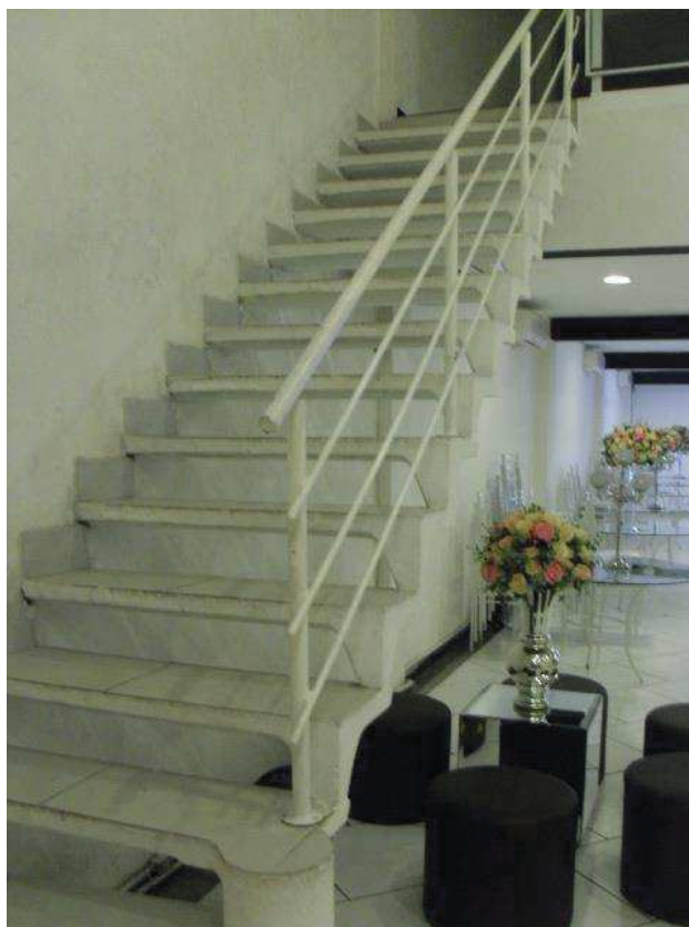
Foto 12 – Escada de acesso ao mezanino
