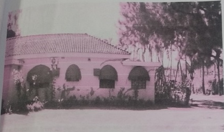
Vista parcial lateral da Casa de Sede do Sítio Duas Irmãs.
