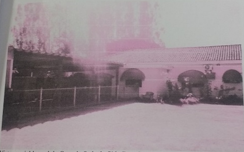
Vista parcial lateral da Casa de Sede do Sítio Duas Irmãs.
