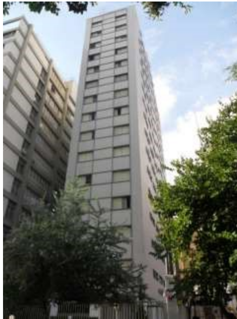
FOTO Nº 01 Vista parcial da fachada Condomínio
