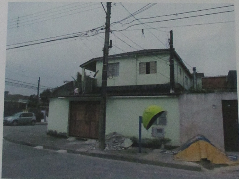
FOTO 03: - Outra vista da fachada do imóvel.
