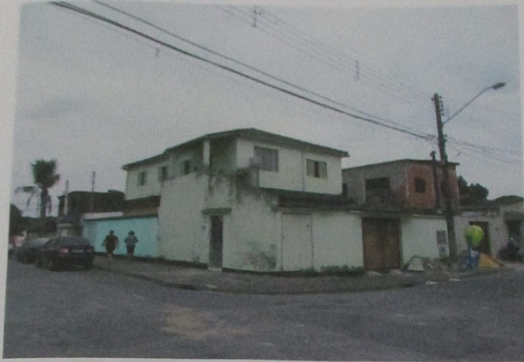
FOTO 02: - Vista da fachada geral do imóvel.
