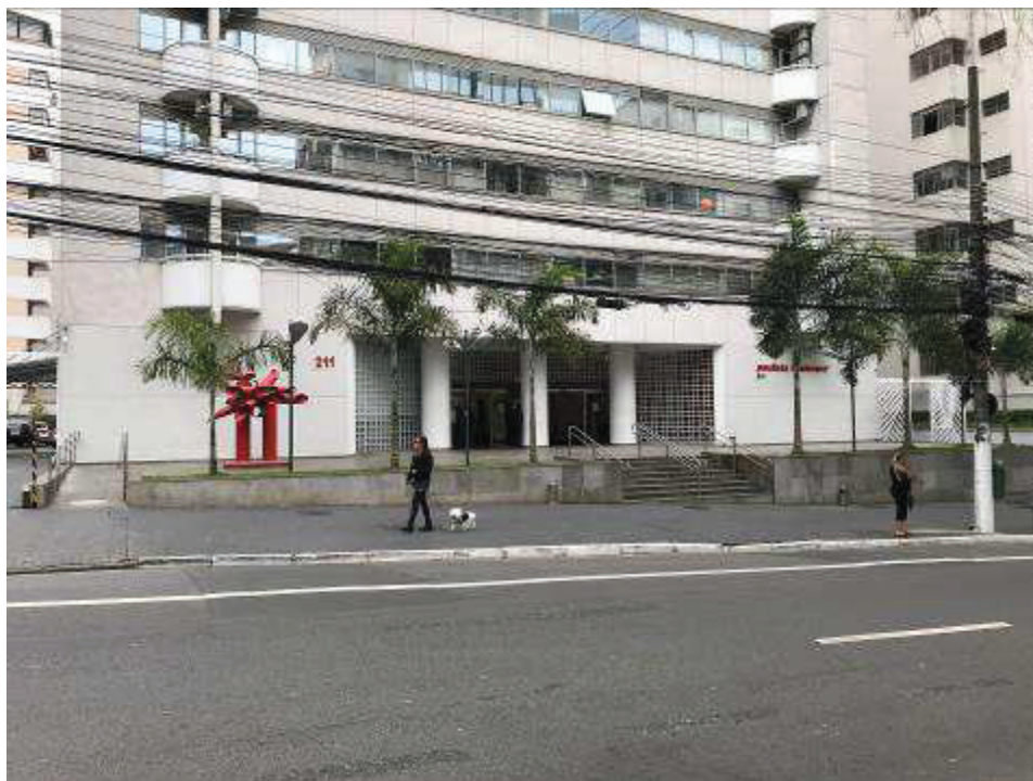
Vista parcial do acesso de pedestres ao Edifício Paulista Boulevard.
