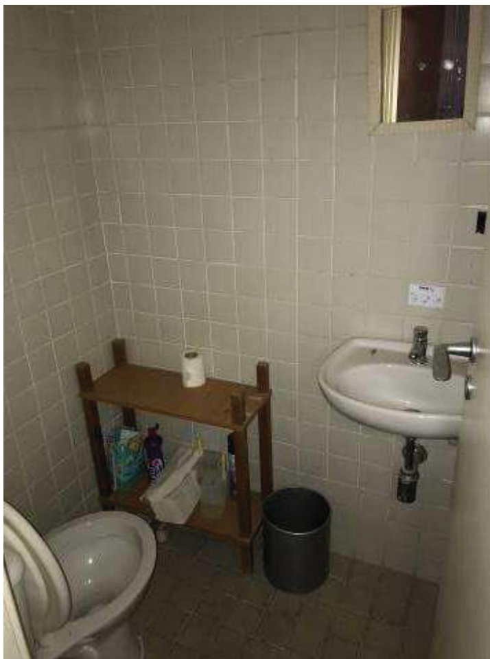
Detalhe de acabamento e estado de conservação do banheiro.
