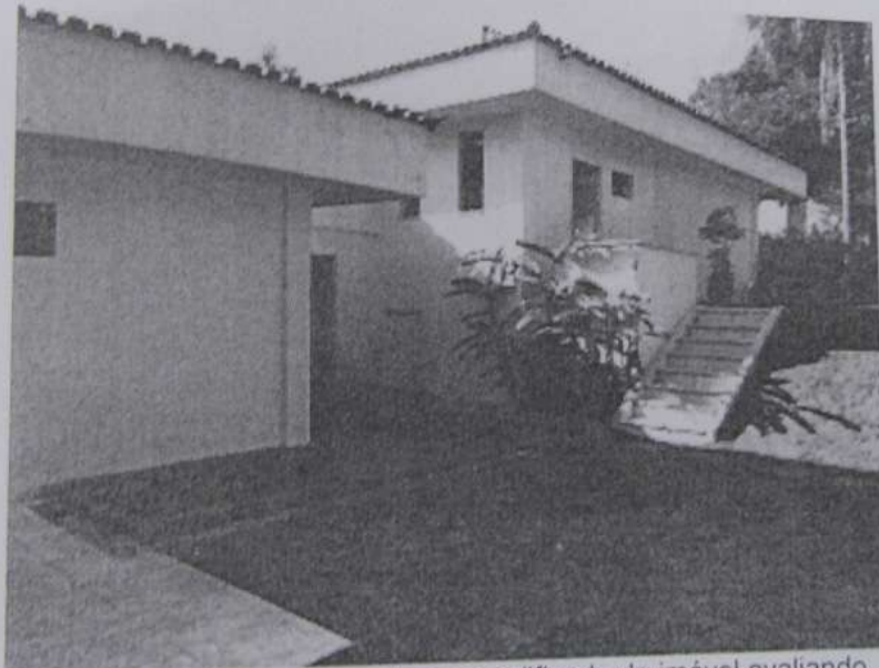
Foto 6: Vista externa da casa edificada do imóvel avaliando.
