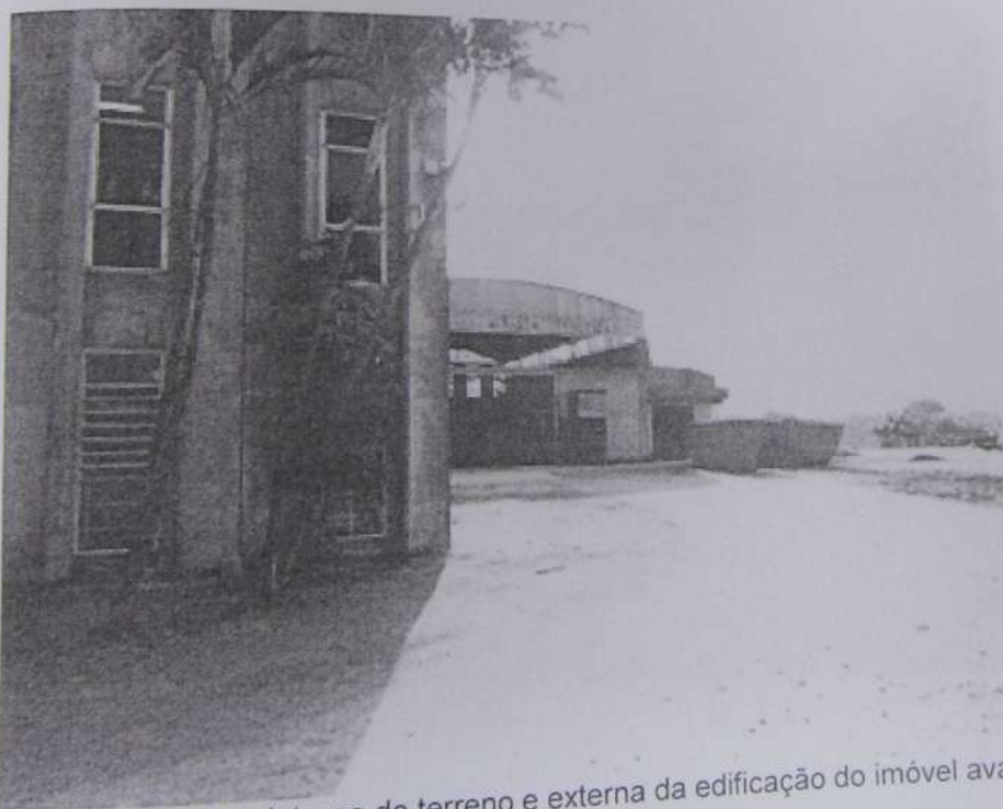
Foto 54: Vista interna do terreno e externa da edificação do imóvel avaliando.
