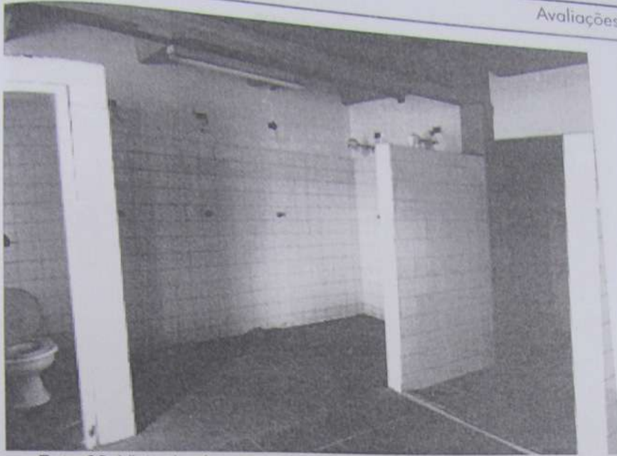
Foto 82: Vista do piso mezanino do galpão.
