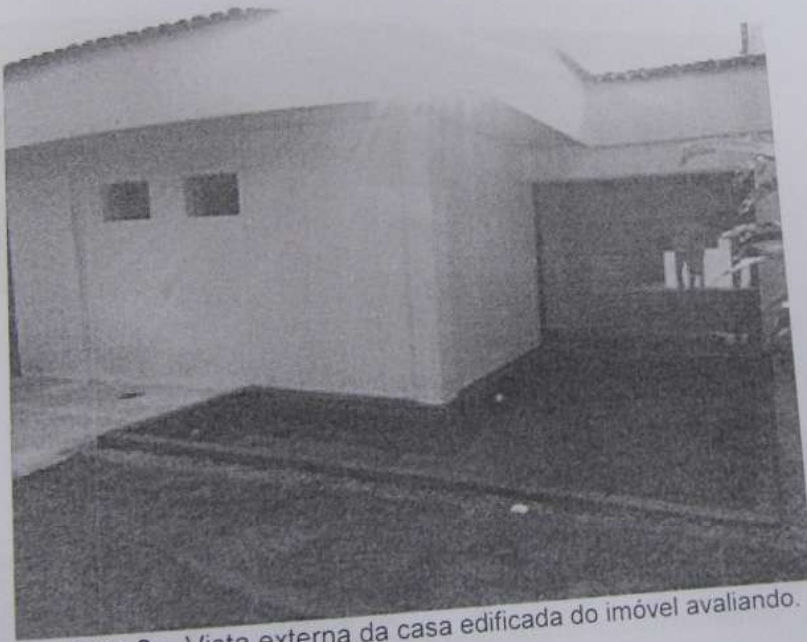
Foto 7: Vista externa da casa edificada do imóvel avaliando.
