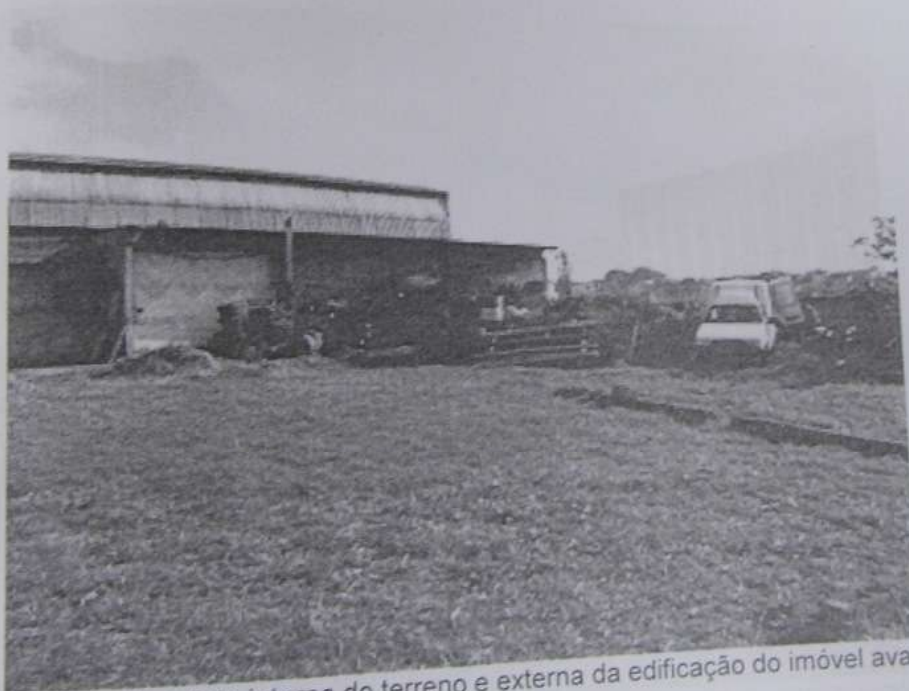
Foto 50: Vista interna do terreno e externa da edificação do imóvel avaliando.
