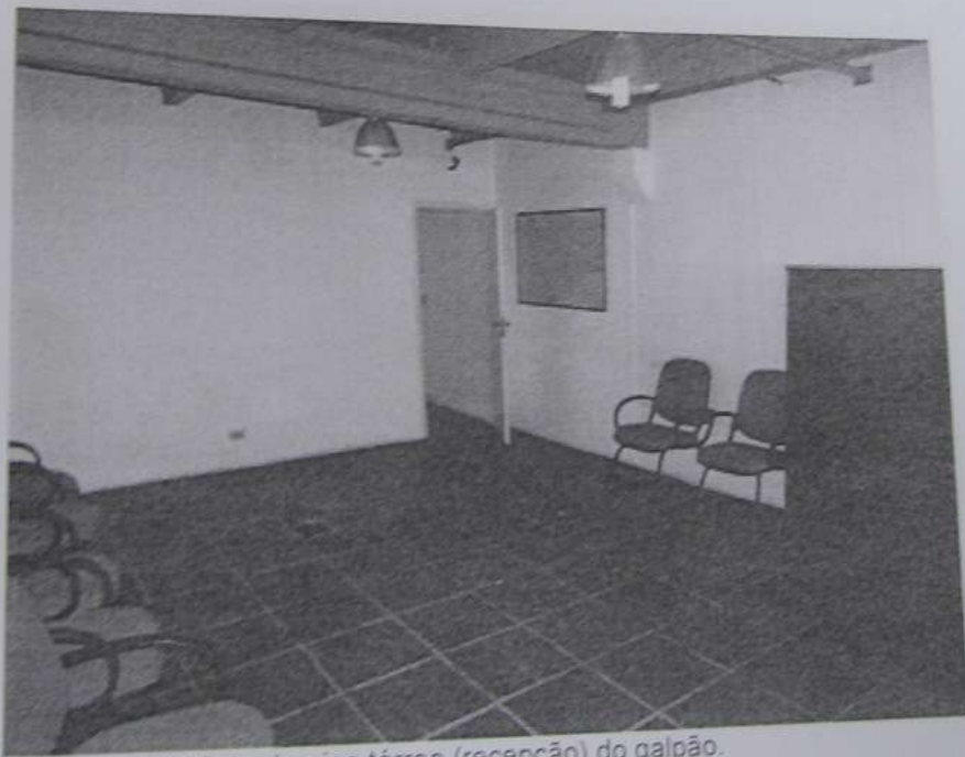
Foto 96: Vista do piso térreo (recepção) do galpão.
