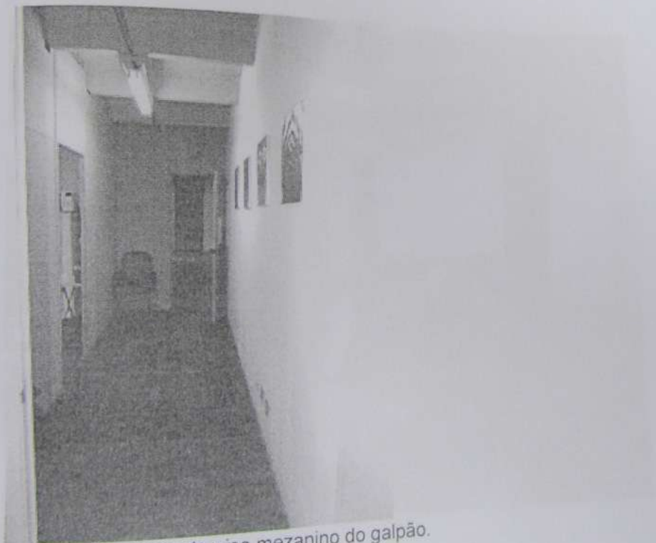
Foto 70: Vista do piso mezanino do galpão.
