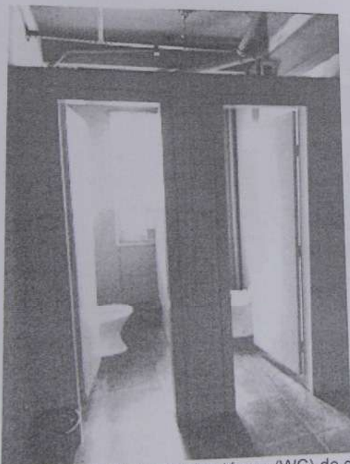
Foto 93: Vista do piso térreo (WC) do galpão.
