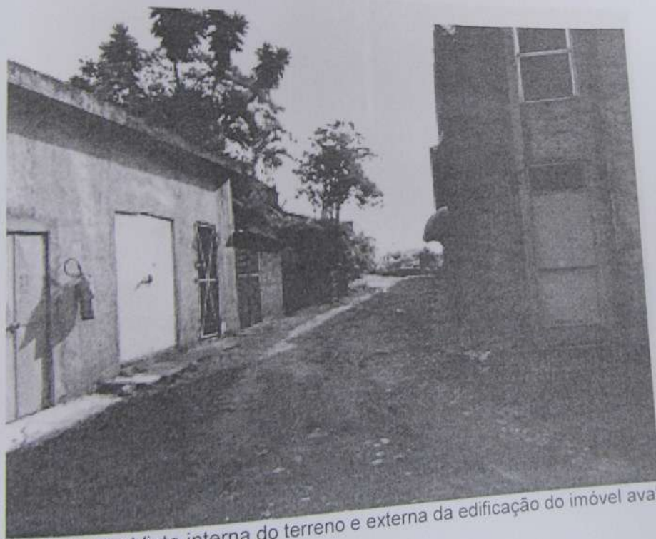
Foto 58: Vista interna do terreno e externa da edificação do imóvel avaliando.
