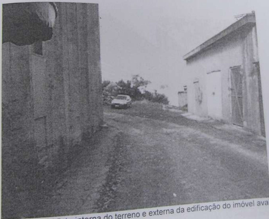
Foto 62: Vista interna do terreno e externa da edificação do imóvel avaliando.
