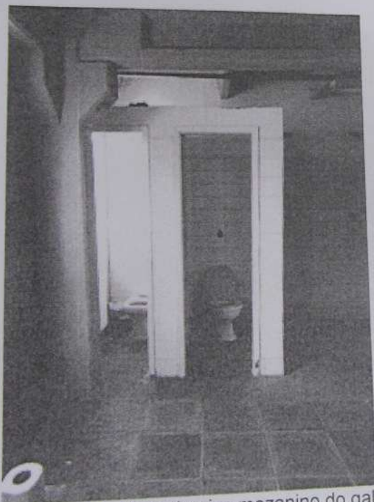
Foto 80: Vista do piso mezanino do galpão.
