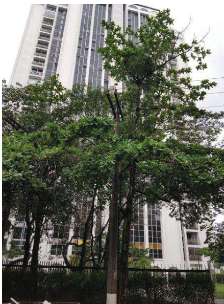
FOTO Nº 01 Vista parcial fachada Edifício Nova Esplanada
