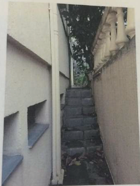
VISTA DA ESCADA DE ACESSO AO JARDIM.
