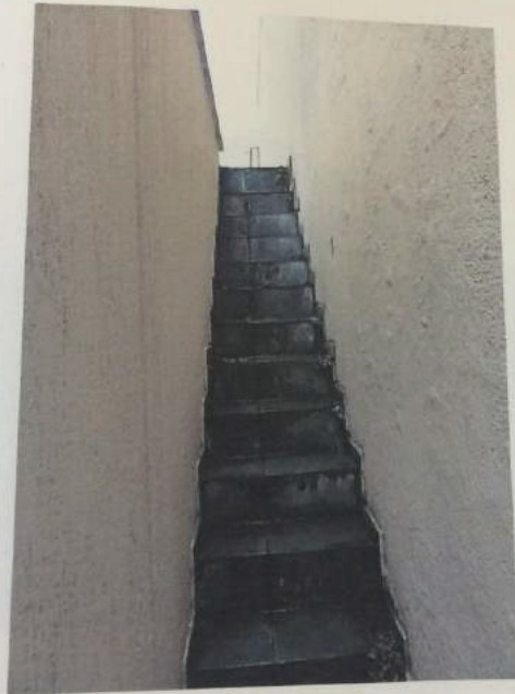
VISTA DA ESCADA DE ACESSO Á AREA DE CHURRASQUEIRA.
