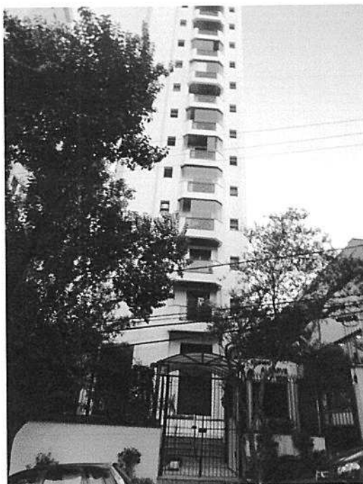
FOTO Nº 15 Vista parcial fachada Edifício Algarve
