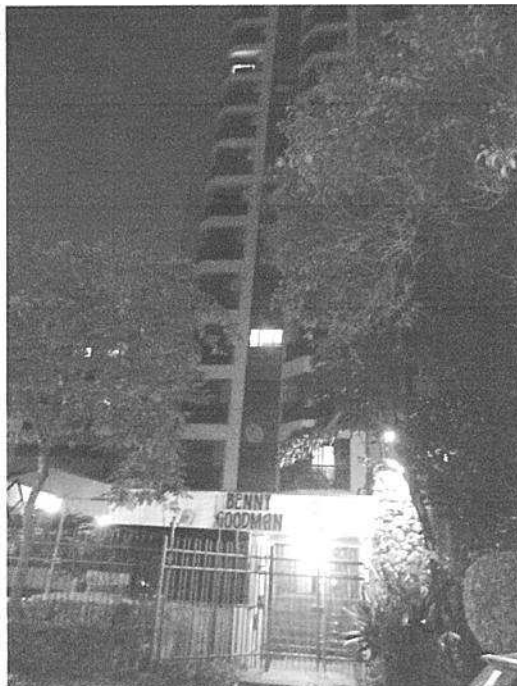
FOTO Nº 01 Vista parcial fachada Edifício Mansão Benny Goodman
