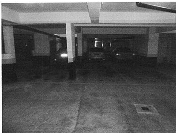
FOTO Nº 24 Vista parcial vagas de garagem
