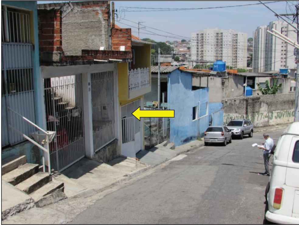
Foto 04.: Vista do imóvel localizado na Rua Carinas.
