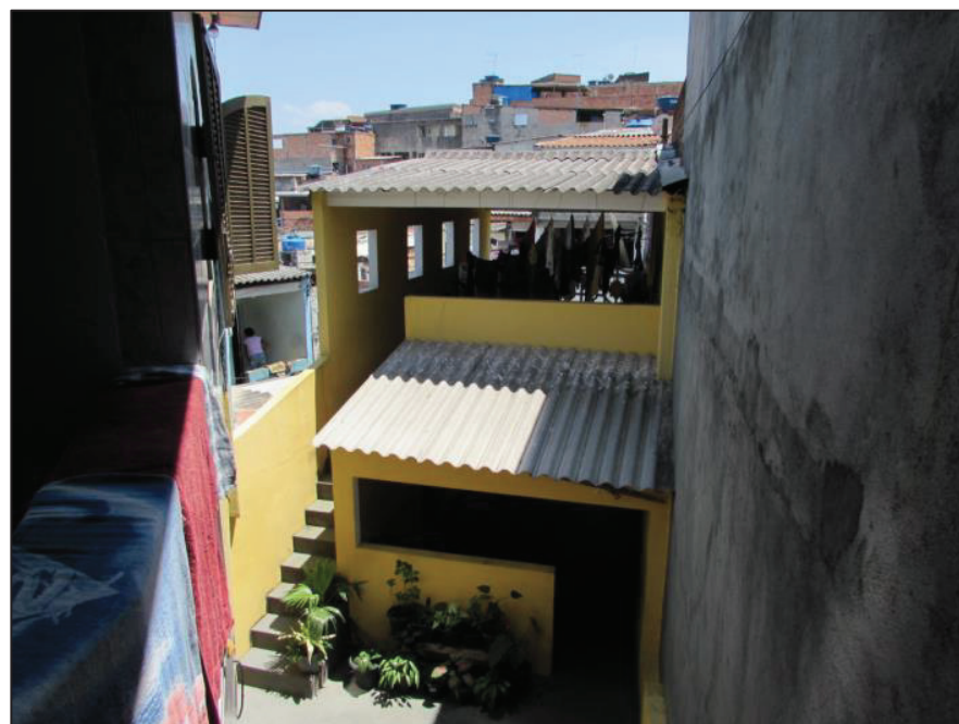
Foto 13.: Vista da Sala com piso cerâmico, paredes revestidas com acabamento e grafiato e caixilhos em alumínio.
