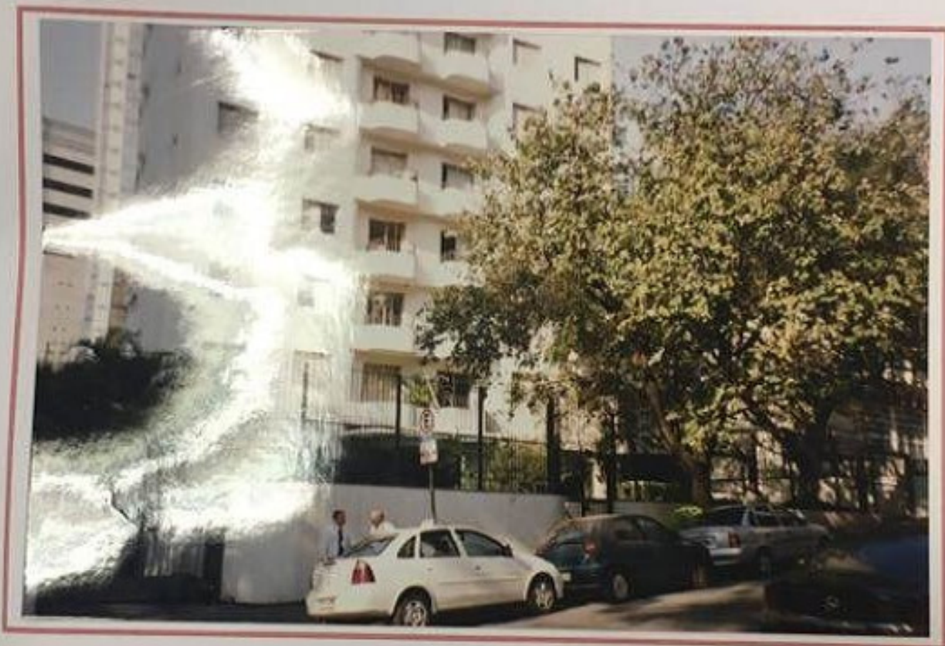
Foto nº 03 – Vista geral da portaria principal do Condomínio, com detalhe para a saída de veículos dos estacionamentos localizados nos subsolos.
