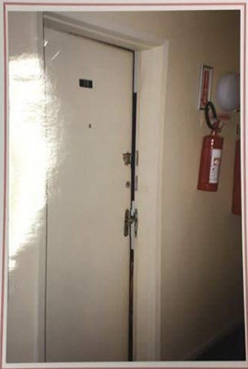
Foto nº 07 – Vista parcial da porta de acesso a unidade avalianda de nº 92.
