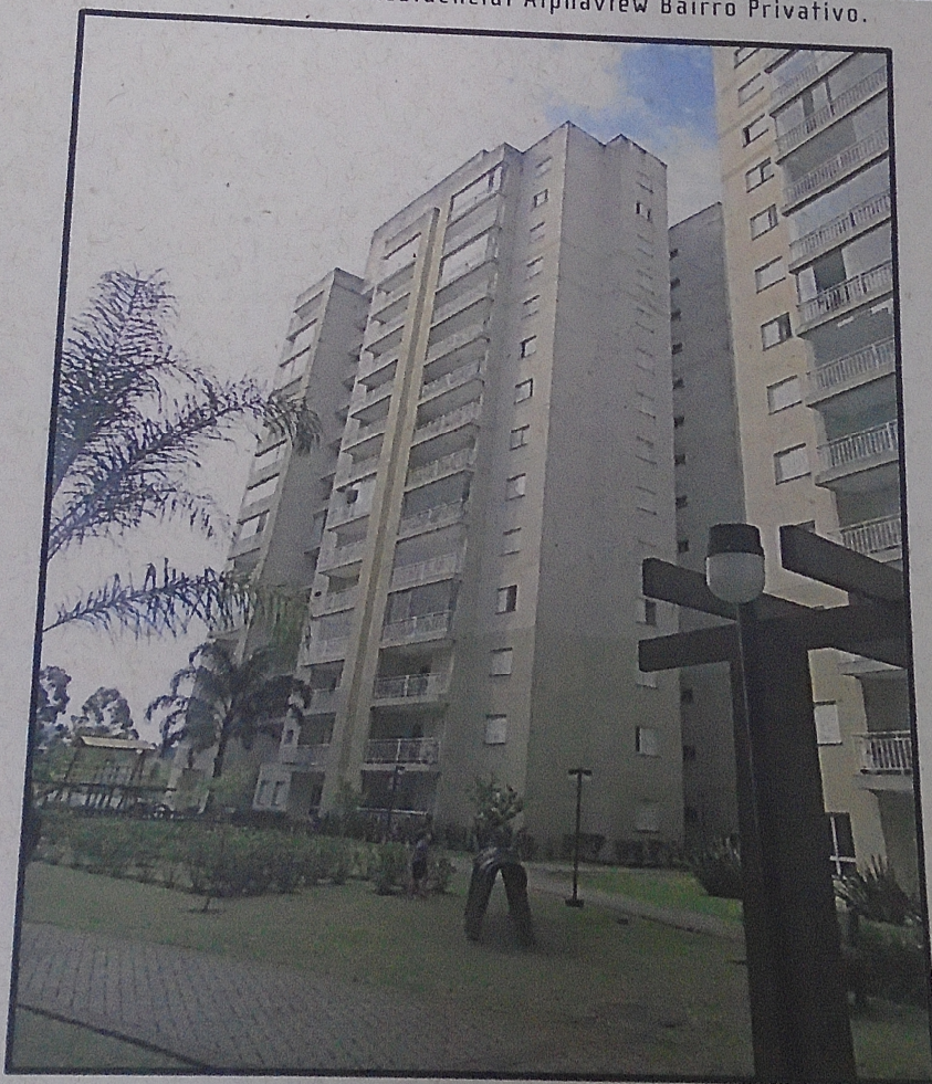
Vista da fachada do Edifício 15
