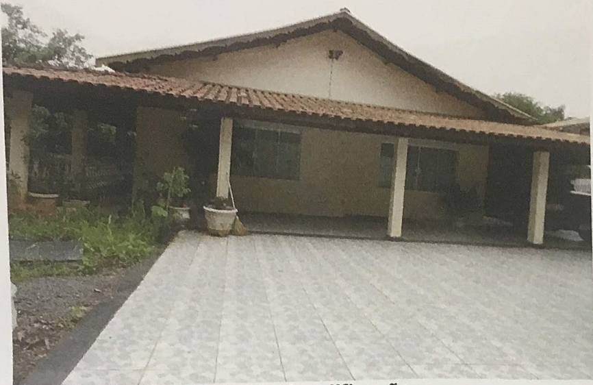
Fachada da edificação.
