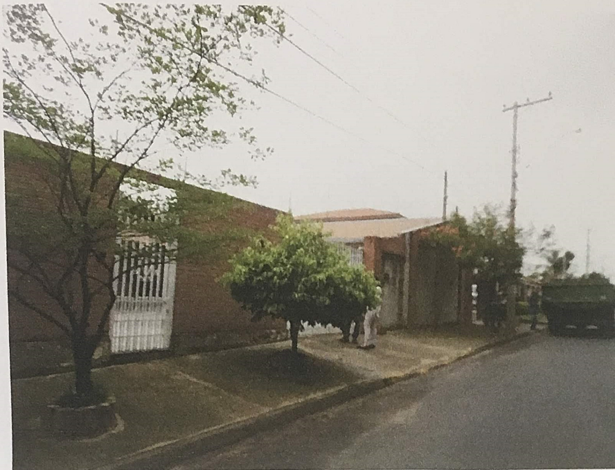
Muro frontal do imóvel objeto da Lide.
