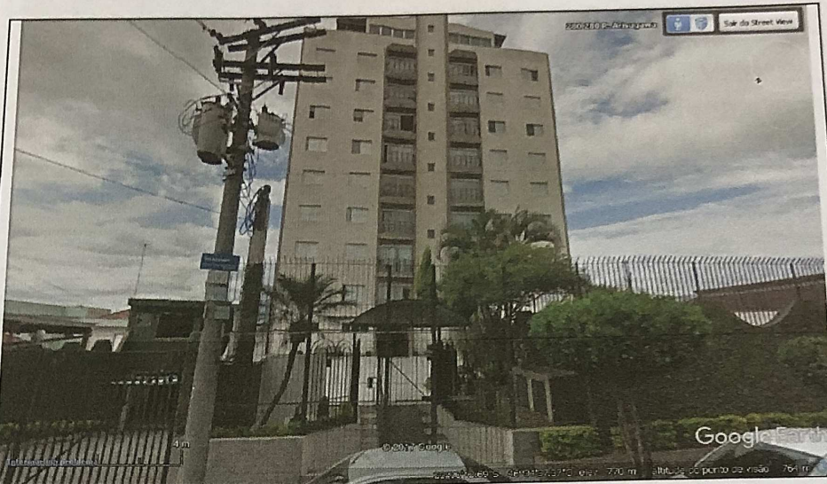
Foto n.º 3. Vista da fachada do Condomínio tomada da rua.
