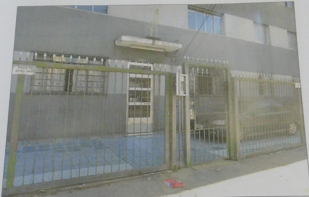
Foto 2. Vista frontal da entrada do Edifício Sonia Regina.
