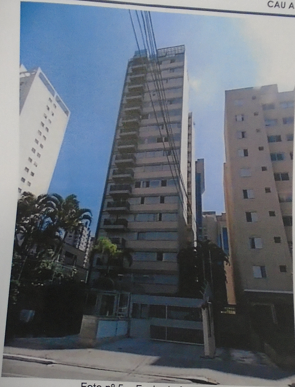
Foto nº 5 – Fachada frontal do imóvel.
