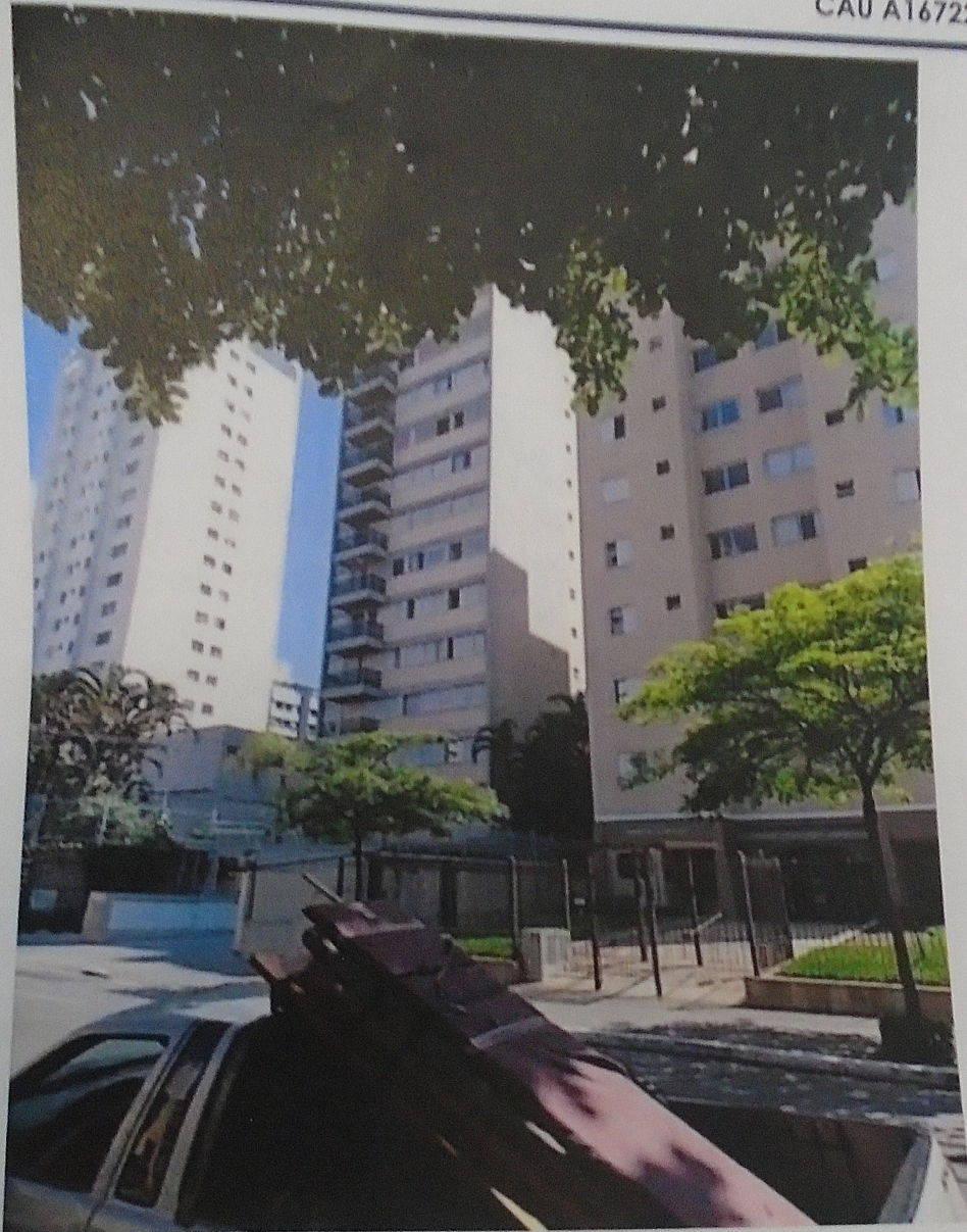
Foto nº 6 – Fachada frontal do imóvel.
