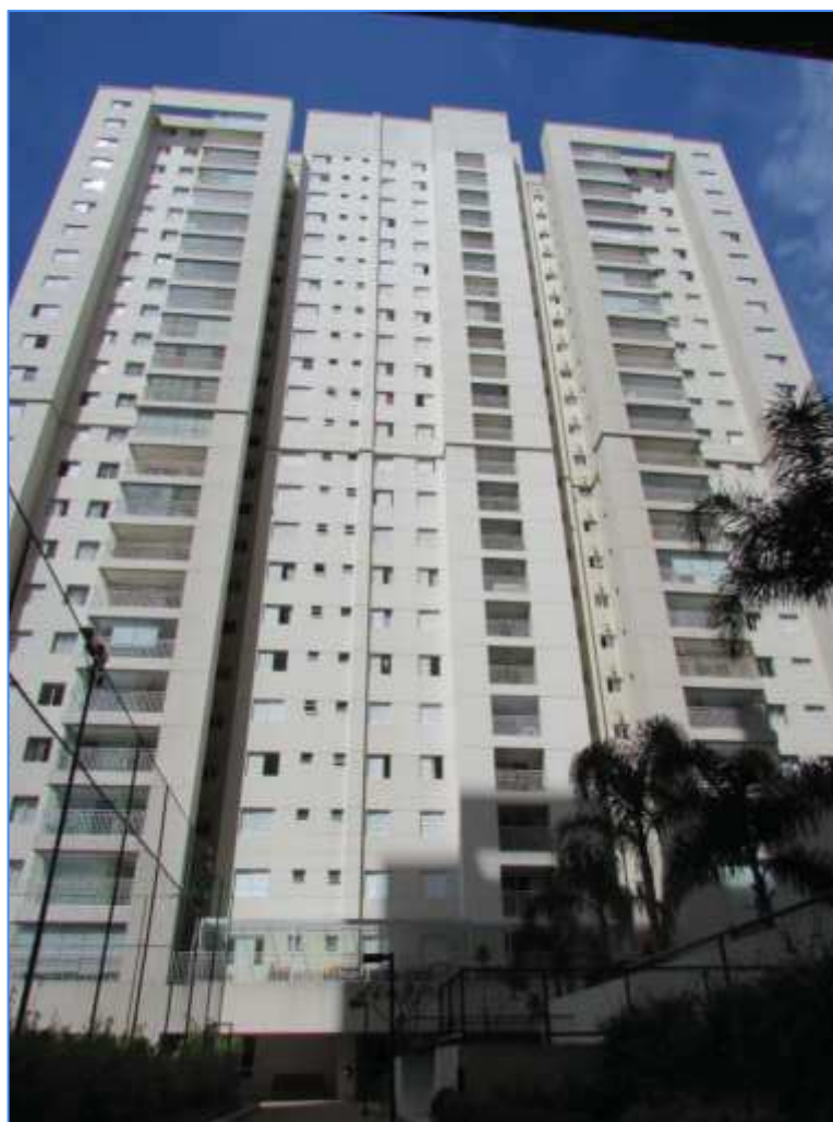
FACHADA DO EDIFÍCIO FELICIDADE.
